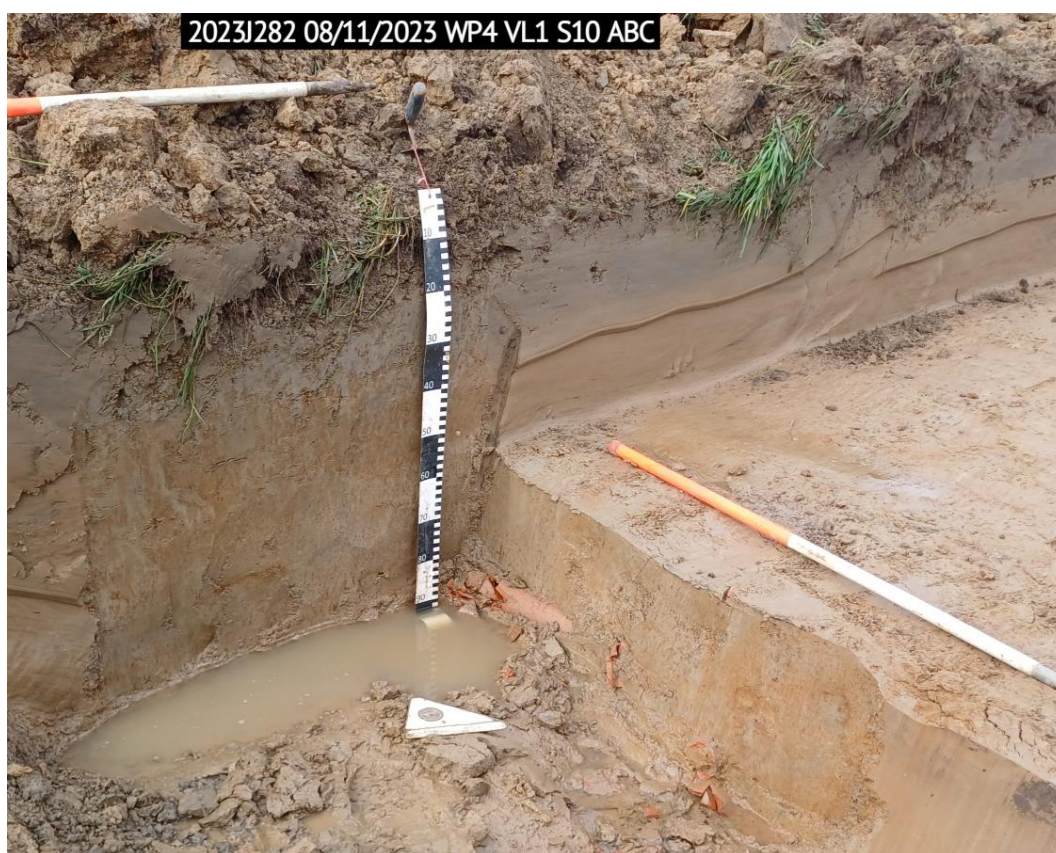
Figuur 66: Werkput 4, drainagebuizen in coupe BC op gracht S10
