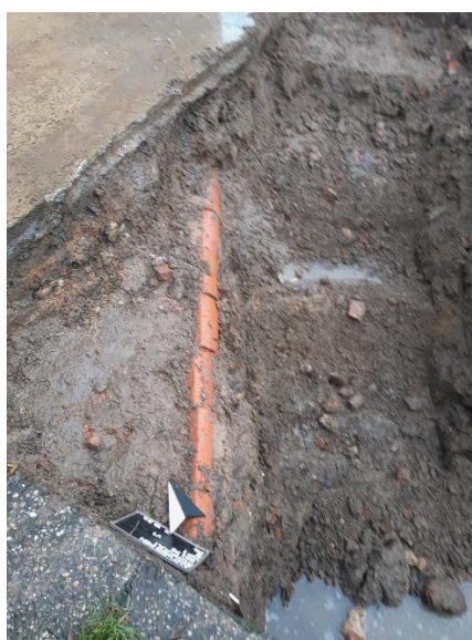
Figuur 37: Foto van afgedekte elektriciteitsleiding in WP 1 (© J. Verrijckt bvba)
