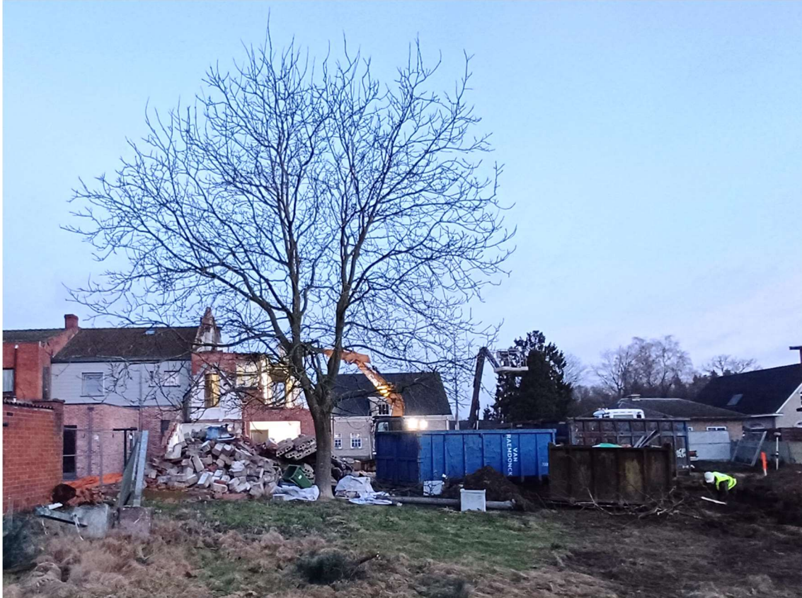
Figuur 31: Werkfoto zone afbraakwerken en te behouden boom in het noorden van het onderzoeksgebied
