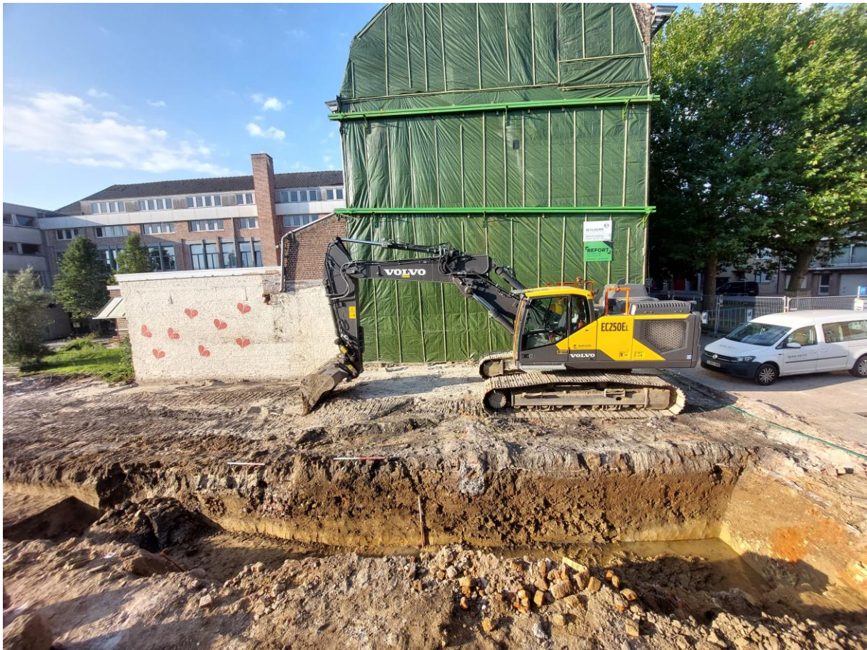
Figuur 4: Toestand van het terrein na aanleg van sleuf 1 ter hoogte van de gesloopte gebouwen. Zicht uit het noorden.
