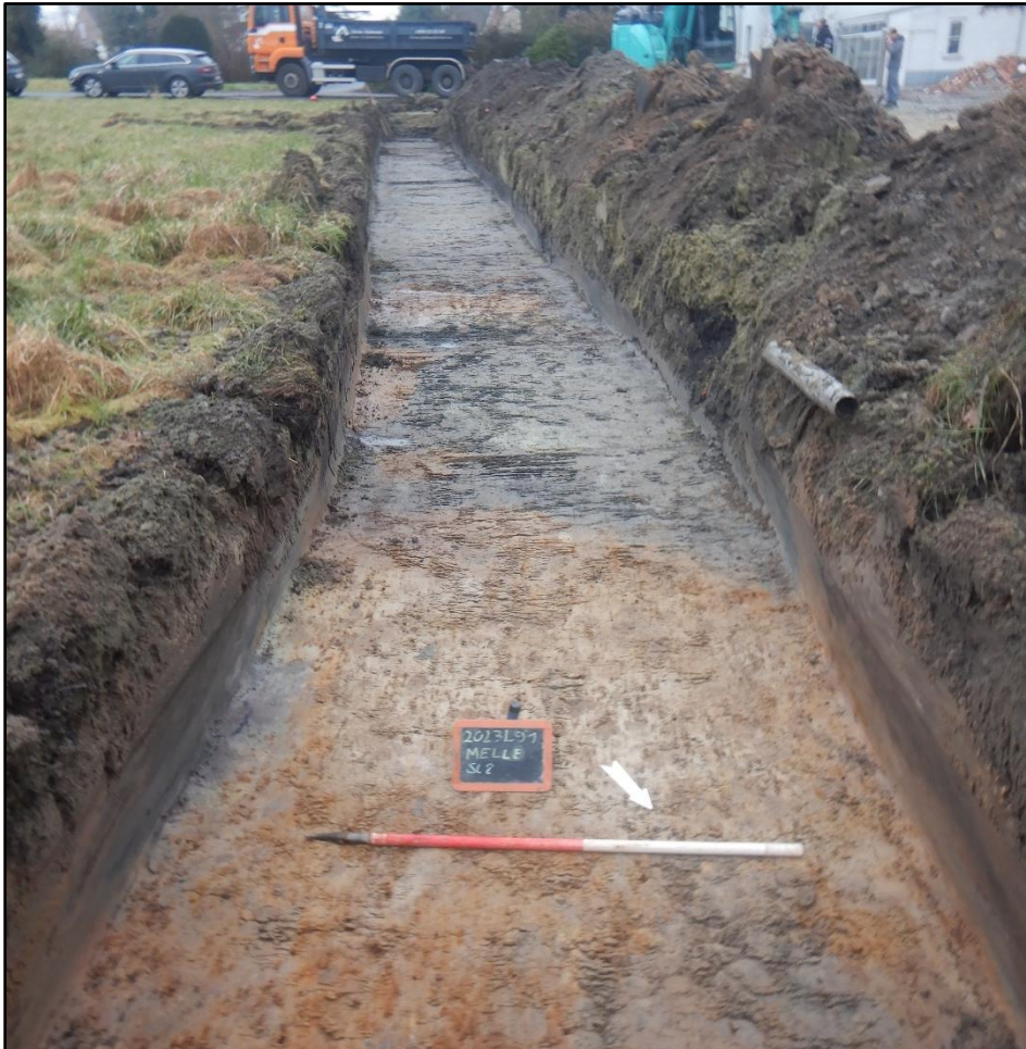
Figuur 15 Zicht op een verstoorde zone in het zuidelijke deel van sleuf 2.
