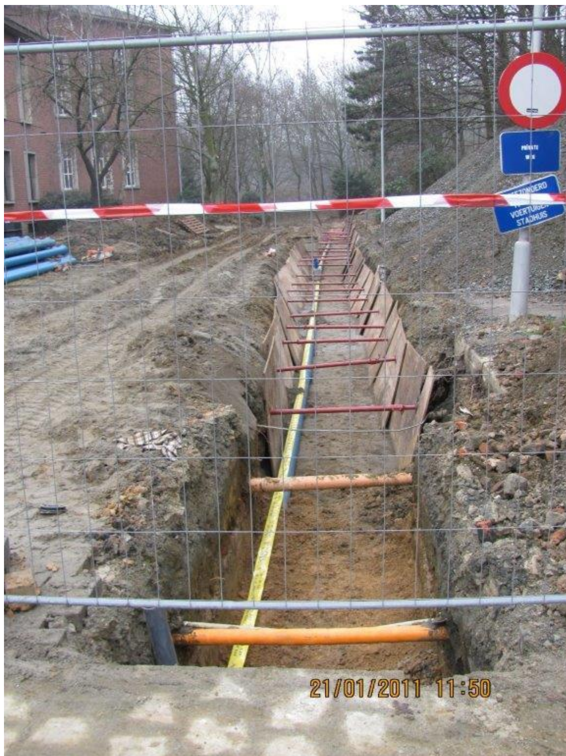
Figuur 3: Sleuf voor nutsvoorzieningen
