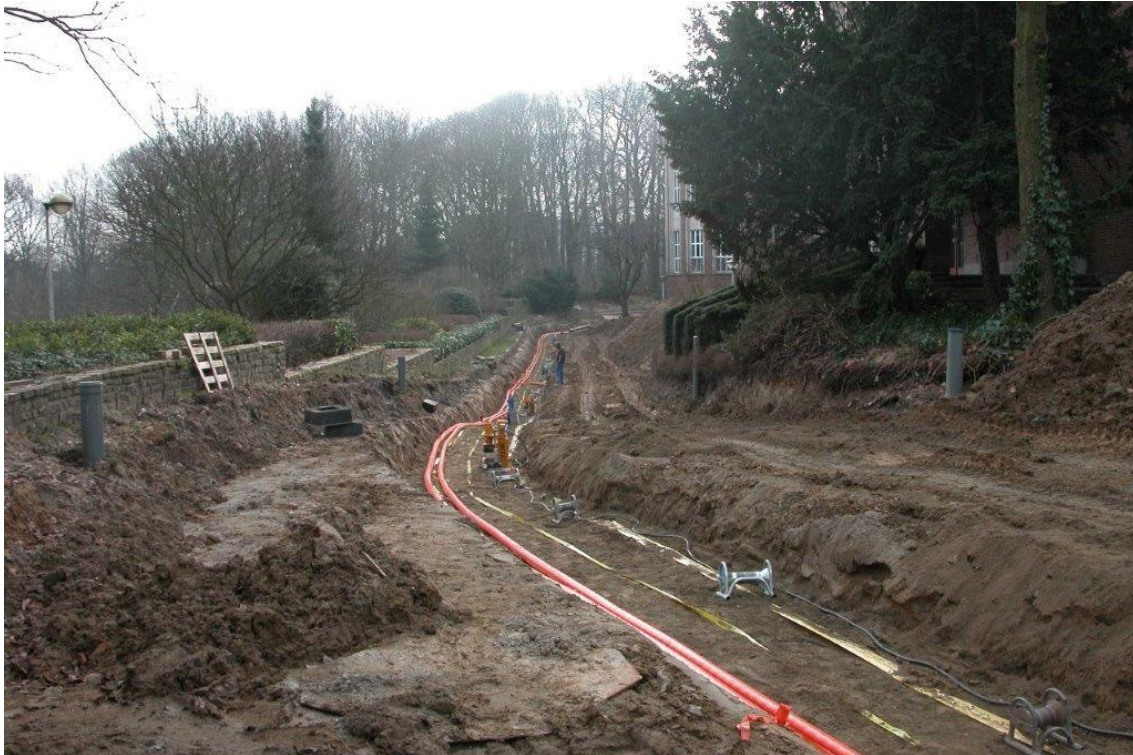
Figuur 4: Sleuf voor nutsvoorzieningen
