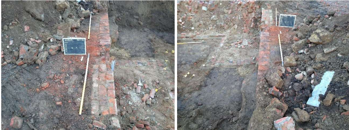
Figuur 15b. Fundering S6 en 12 in vlak 1, werkput 1. ©LARES
