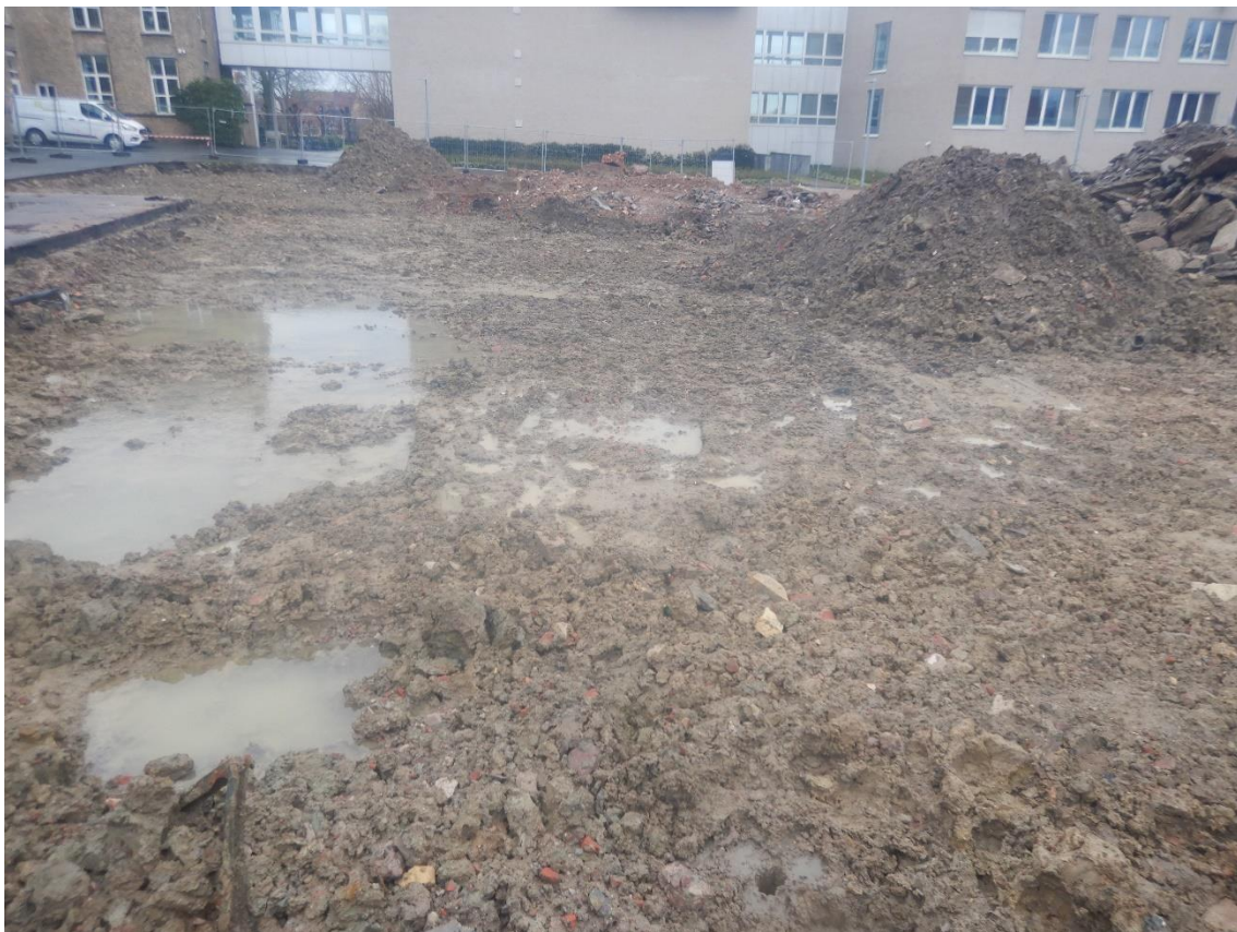
Figuur 11: Sfeerbeeld van het terrein ter hoogte van het gesloopte gebouw.
