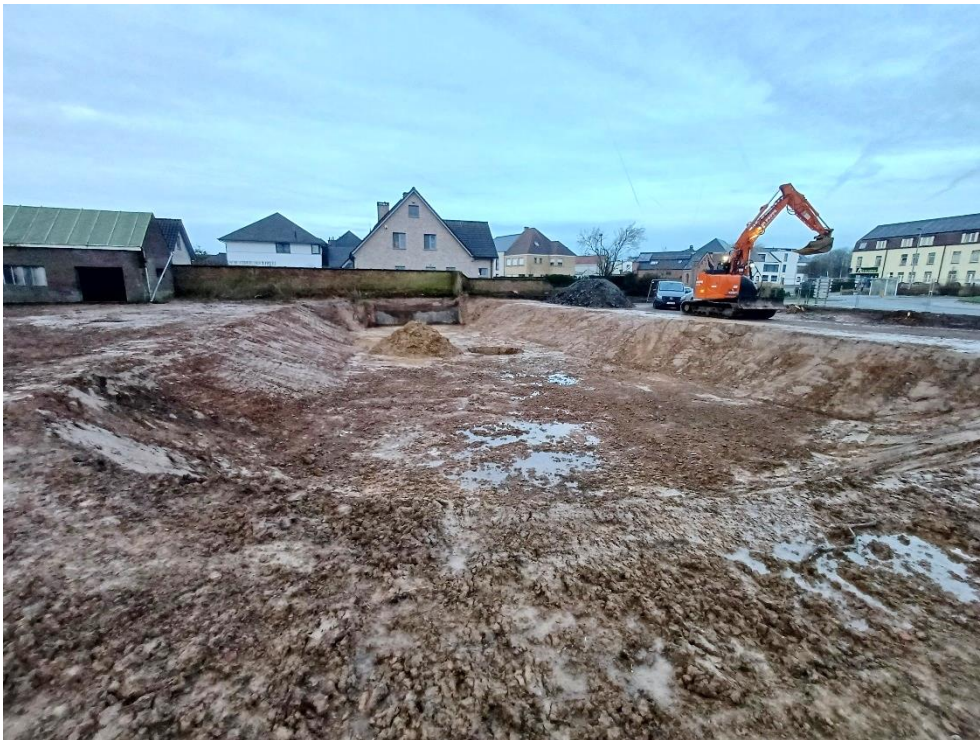
Figuur 10: Werkfoto uitgegraven kelder centraal op het terrein
