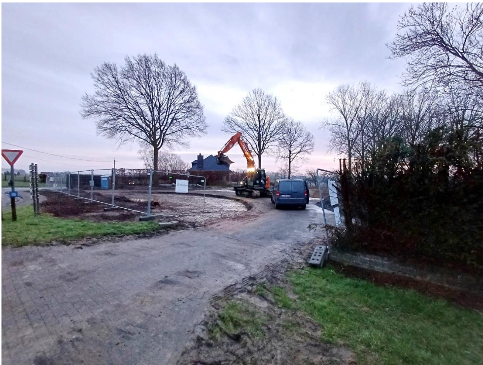
Figuur 9: Werkfoto verharde oprit
