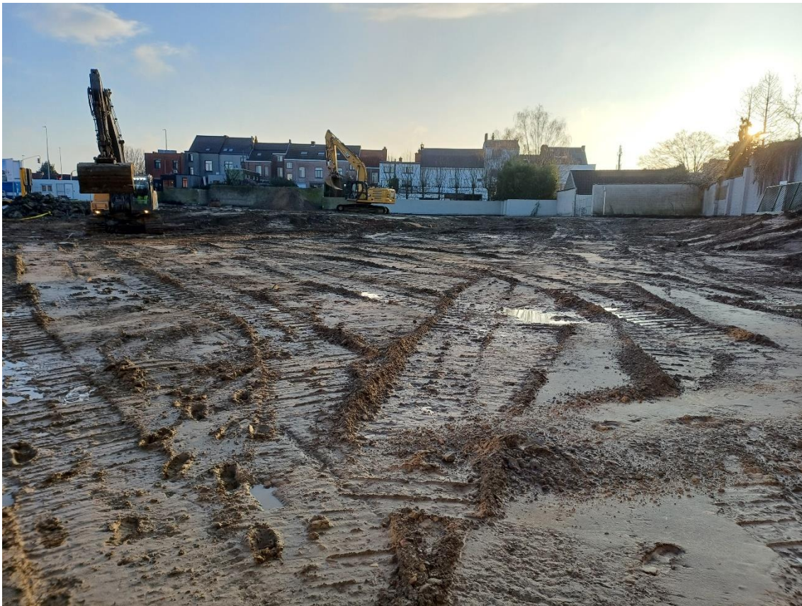
Figuur 5: Toestand van het terrein bij aanvang van het proefsleuvenonderzoek
