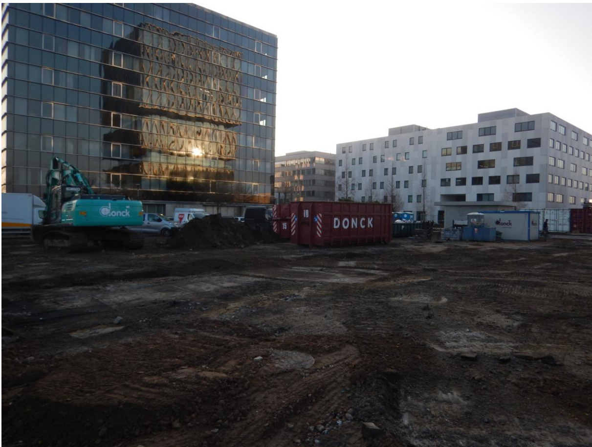
Figuur 5: Aanwezige containers en gebruikte werfparking.
