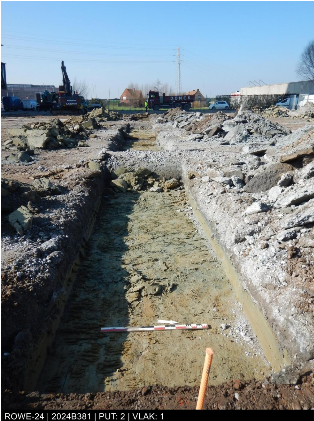
Figuur 18: Zicht op Sleuf 2.
