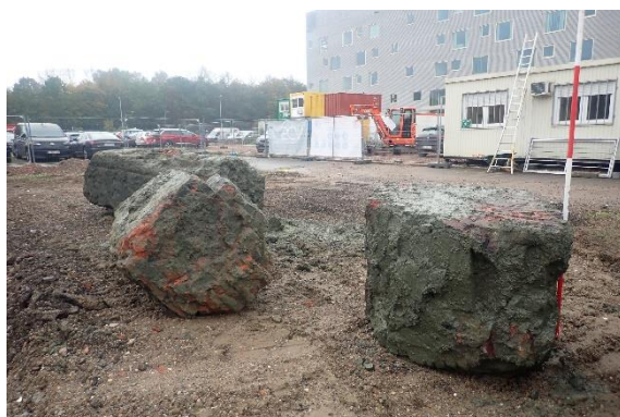
Figuur 21. Voorbeelden van de brokstukken van bakstenen massieven die binnen de bouwput en o.a. in het noordelijke deel van WP1 werden uitgegraven.
