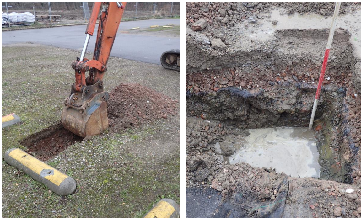
Figuur 10 a/b. Het was niet mogelijk om handmatig vanaf het maaiveld te boren. Een minigraver werd ingezet om de bovenste lagen steenslag weg te graven en zo het boorgat voor te bereiden. Het snel instromende water vormde een bijkomende belemmering van de werkzaamheden.
