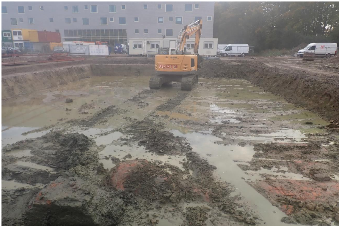
Figuur 14. Door de erg natte werkomstandigheden moesten er machinaal afwateringsgeulen en dammetjes aangelegd worden om de proefsleuven droog te houden.
