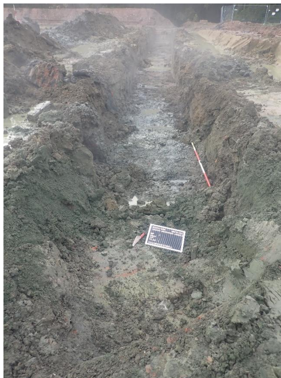
Figuur 16. WP1: zicht vanuit het noorden; hier werden brokstukken van zware bakstenen massieven verwijderd.
