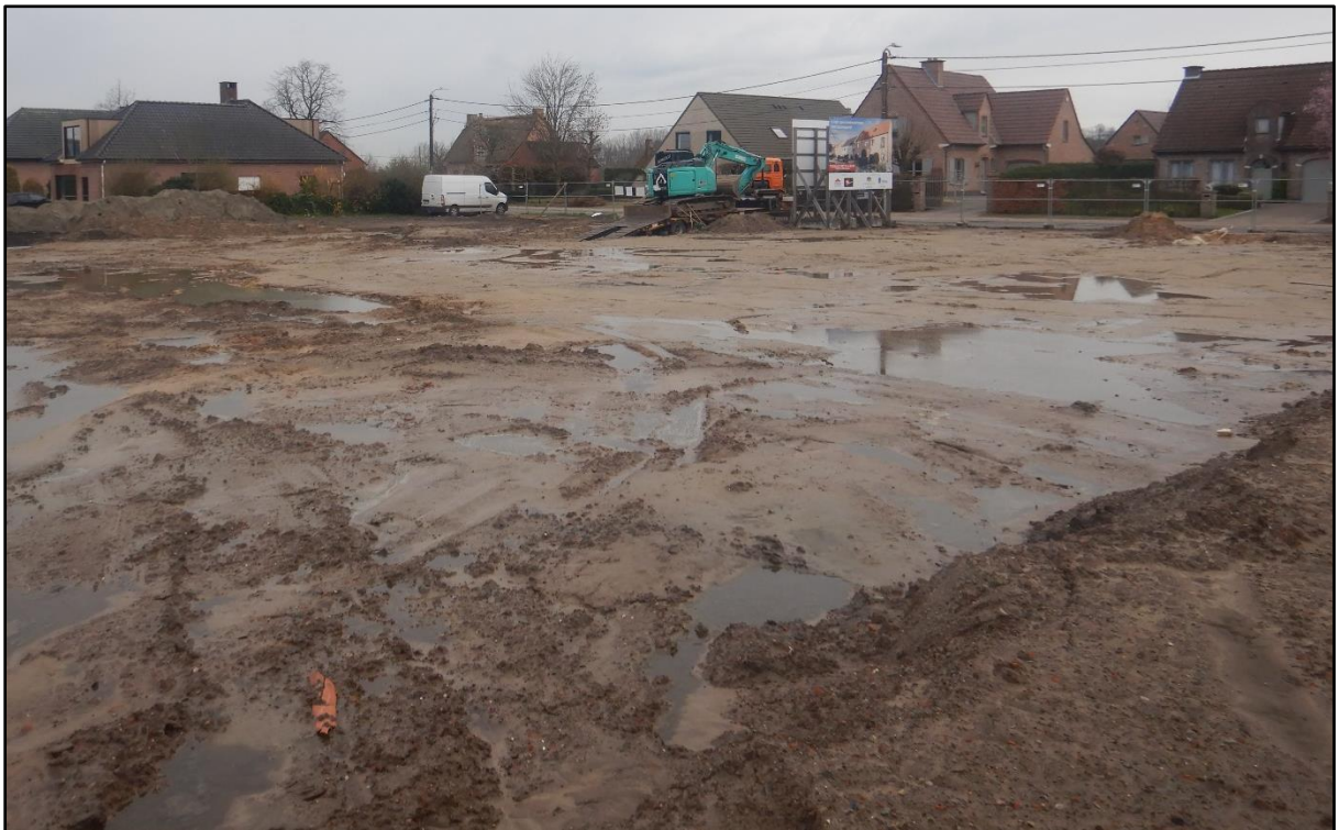
Figuur 2 Zicht op het plangebied na de bovengrondse sloop.
