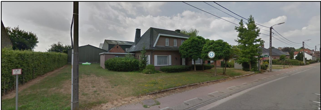
Figuur 1 Beeld op de woning met tuin en achterliggende loodsen, gezien vanaf de Doornstraat, voor de bovengrondse sloop (bron: https://www.google.com/maps ).
