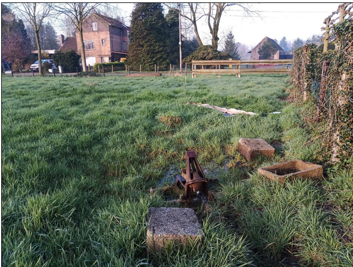
Figuur 3: Zicht in westelijke richting op het onderzoeksgebied op de locatie waar het pompstation zal worden aangelegd met bijhorende werkzone langs de Axelsvaardeken (ABO nv 2024).
