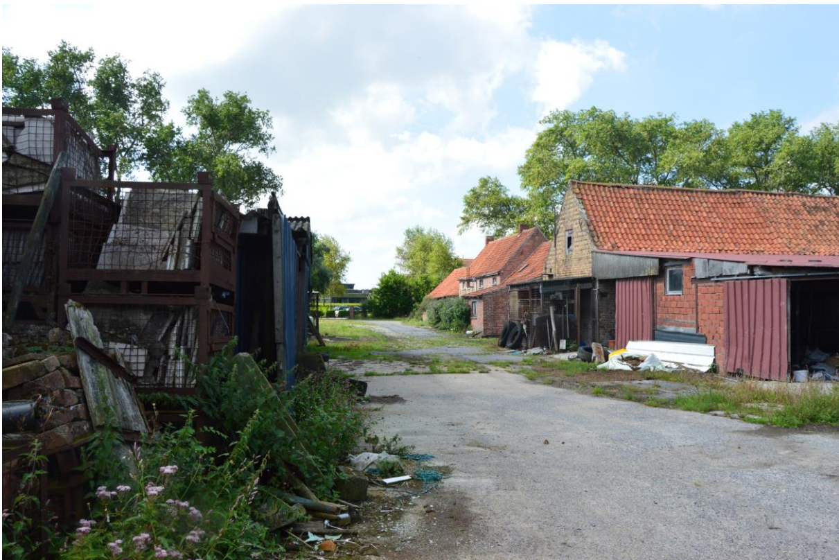
Figuur 6: Zicht op het bestaande hoevecomplex. Deze bebouwing blijft behouden. (Bron: Opdrachtgever).
