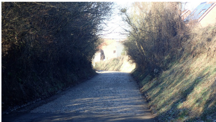
Figuur 13. Zicht op de 'holle' Hoegaardsestraat vanuit het zuidoosten.
