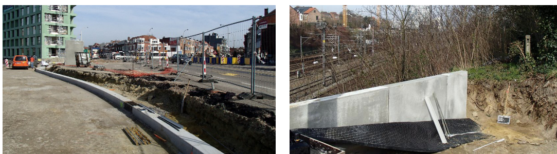
Figuur 21. Boringen 1 en 2 werden geplaatst langs de oostelijke rand van de huidige bouwput, binnen het tracé van de toekomstige werken voor het nieuwe fietspad (links). Boring 3 werd geplaatst in de zuidwestelijke hoek van de bouwput, op de top van de oostelijke talud van de spoorwegbedding (rechts).
