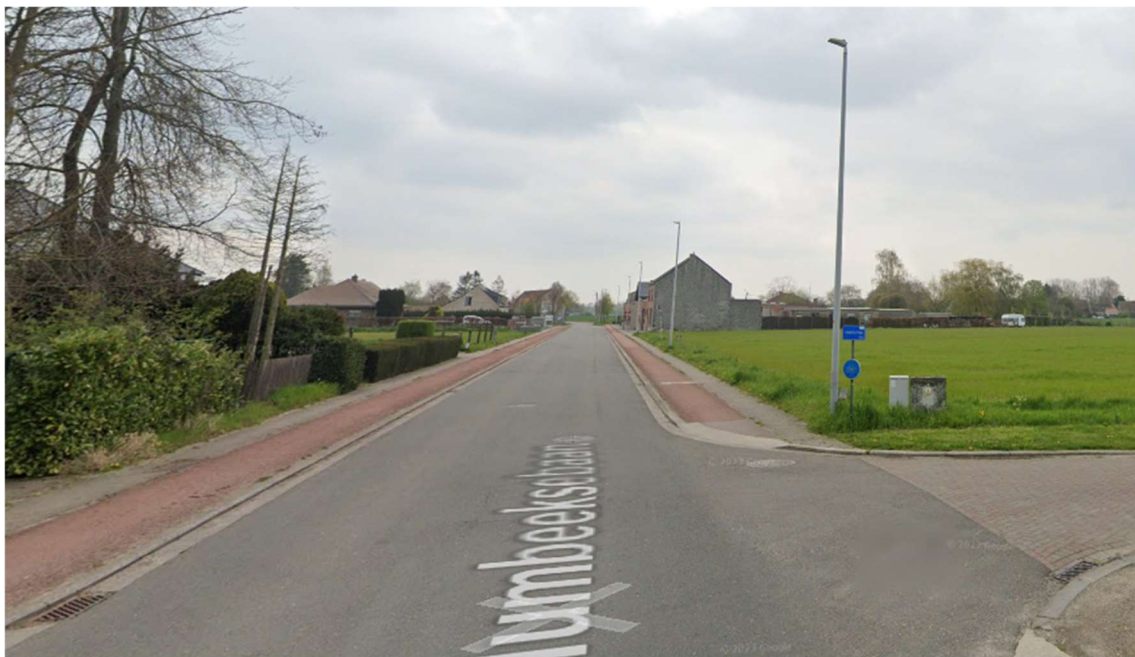
Fig. 1.18: Huidige toestand Humbeeksebaan (ter hoogte van kruising met Vekeputtenweg) met rechts de akker waarvan een deel wordt ingenomen t.b.v. de geplande open grachten (© Google Maps).
