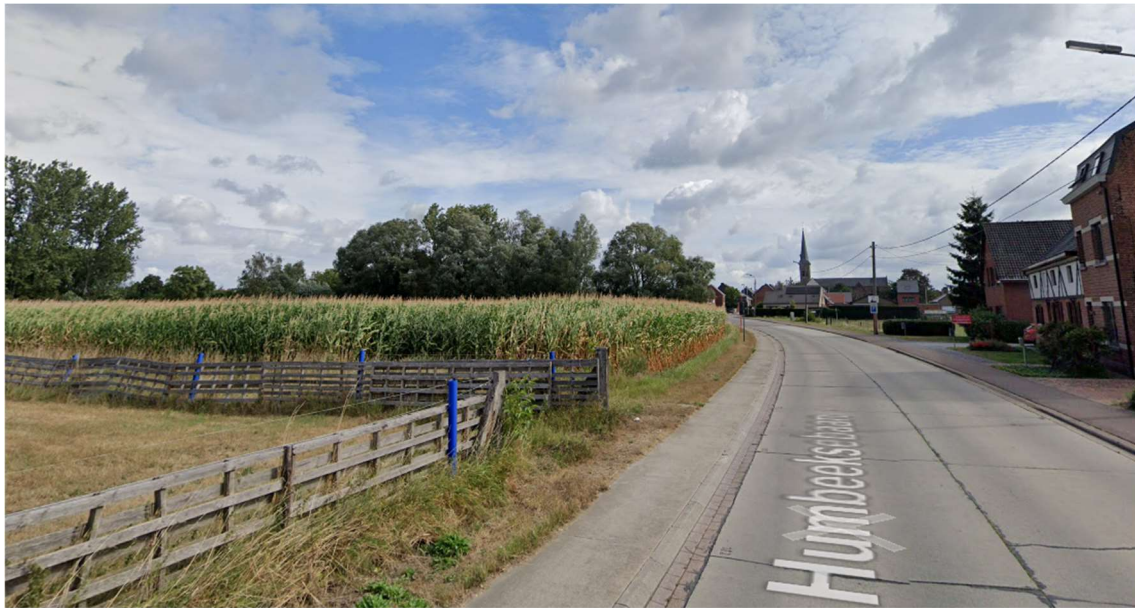
Fig. 1.15: Huidige toestand Humbeeksebaan met links het terrein voor grondverbetering (© Google Maps).
