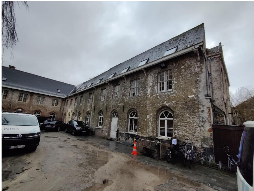
Figuur 2a-b: zicht op bestaande toestand binnenkoer (bron: eigen opname)
