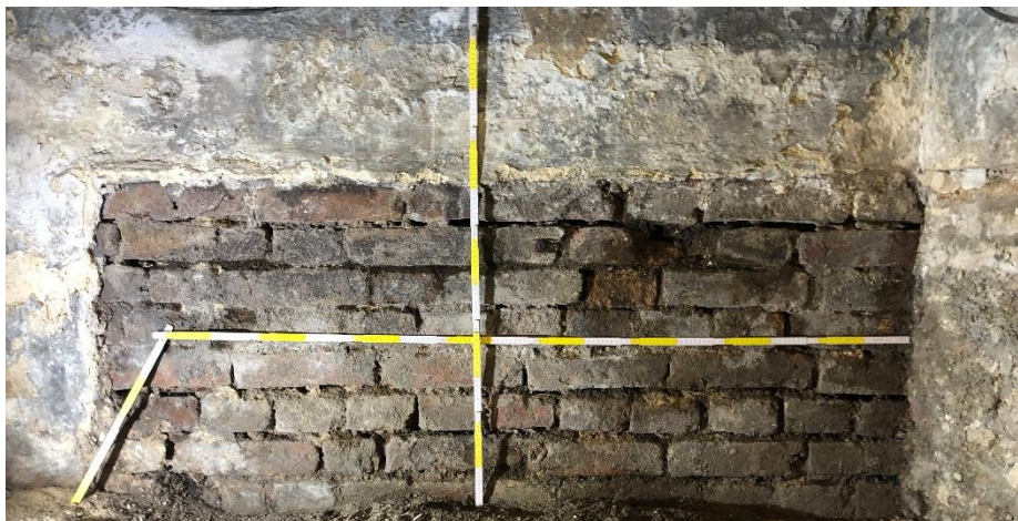
Figuur 13: opgaand metselwerk uit de 13 de eeuw (bron: opname T.Wets, DME stad Brugge)
