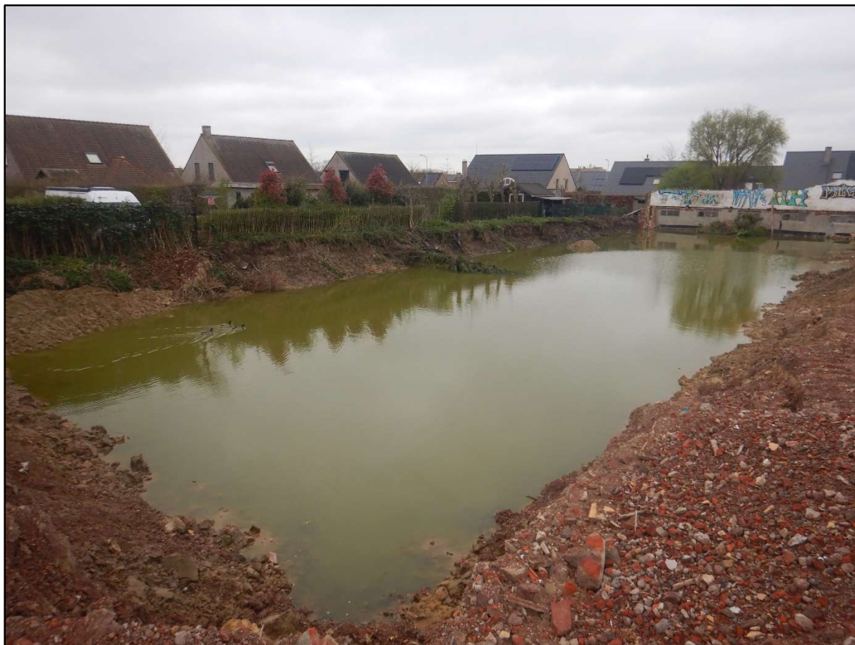
Figuur 8 Zicht vanuit het zuidoosten op de uitgraving van de kelder langs de noordwestelijke kant van het terrein.
