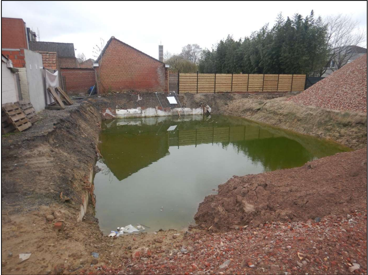
Figuur 7 Zicht vanuit het oosten op de uitgraving van de kelder in de zuidwestelijke hoek van het terrein.
