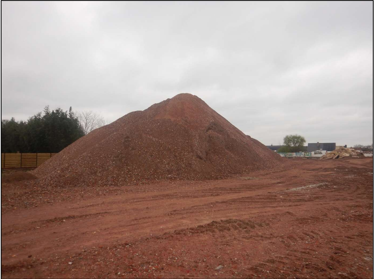
Figuur 5 Uitgespreid en gestapeld steenpuin op het terrein.
