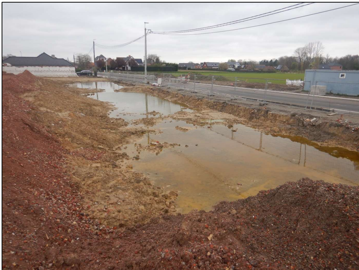
Figuur 9 Zicht vanuit het zuiden op de uitgraving van de kelder langs de noordoostelijke kant van het terrein.
