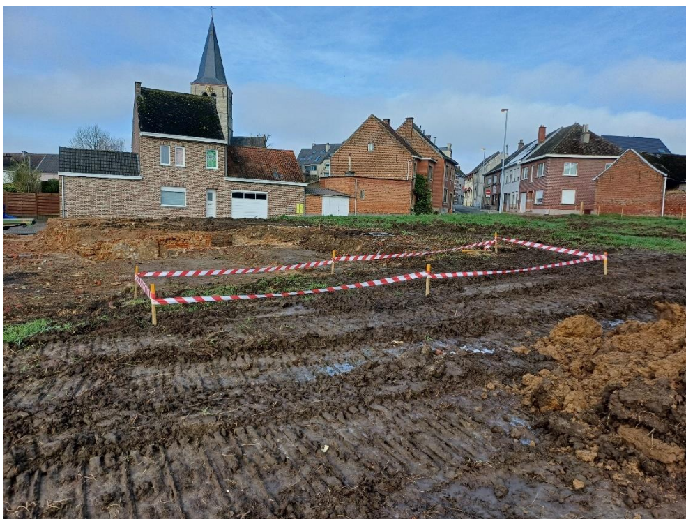
Figuur 18: Werkfoto afgebakende zone met asbest
