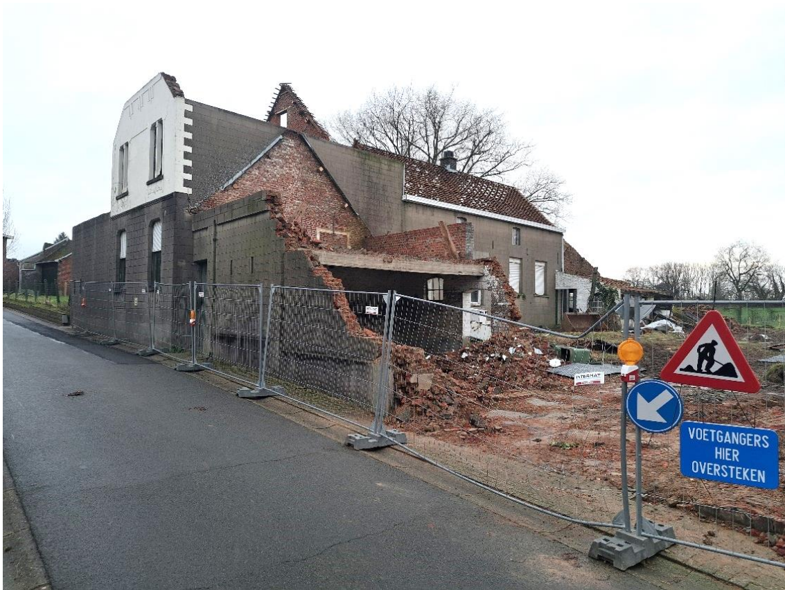
Figuur 45: De hoeve tijdens de sloop
