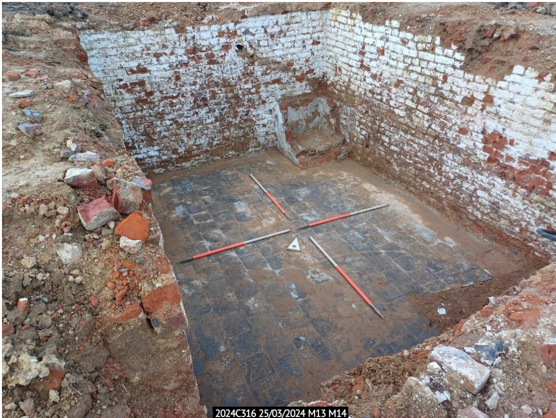
2024C316 25/03/2024 M13 M14 Figuur 49: Kelder K2, muur M13 en vloer M14
