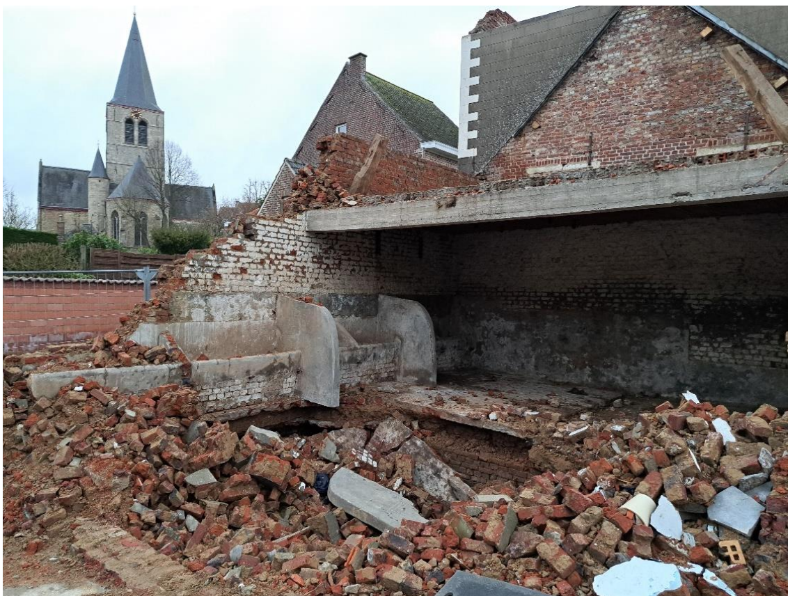
Figuur 47: Beerput M15 (K3) onder de stallen
