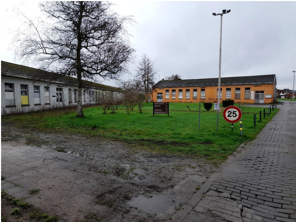
Figuur 8: Foto 3 bestaande toestand
