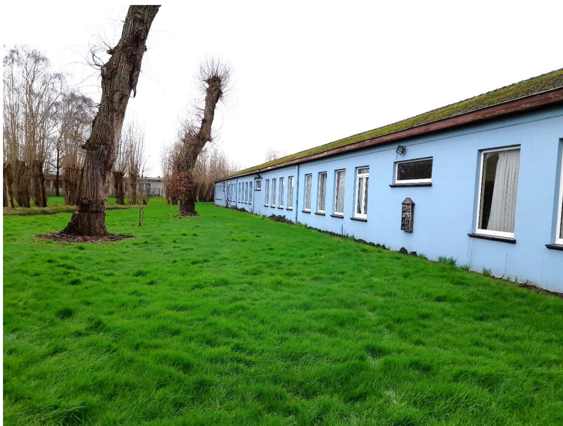
Figuur 15: Foto 10 bestaande toestand
