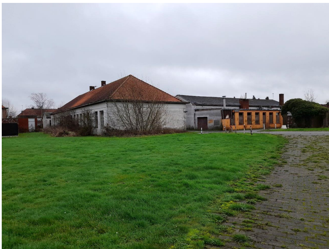
Figuur 7: Foto 2 bestaande toestand
