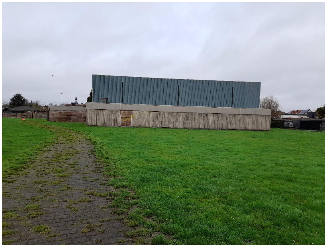
Figuur 6: Foto 1 bestaande toestand
