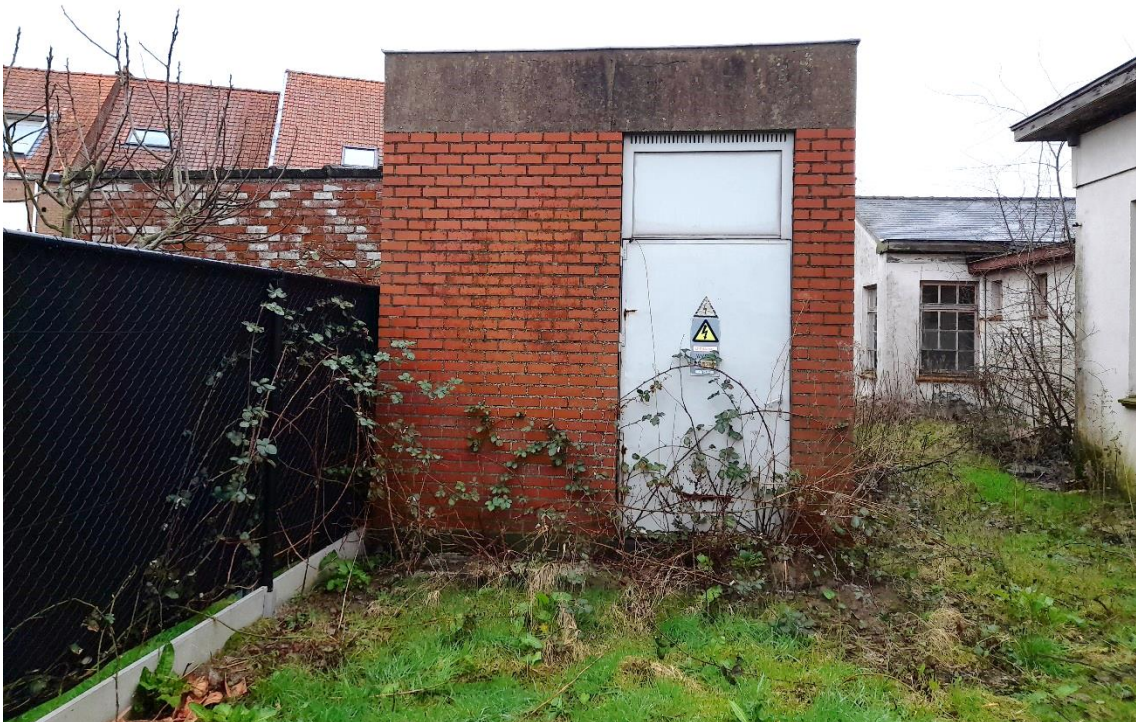
Figuur 17: Foto 12 bestaande toestand
