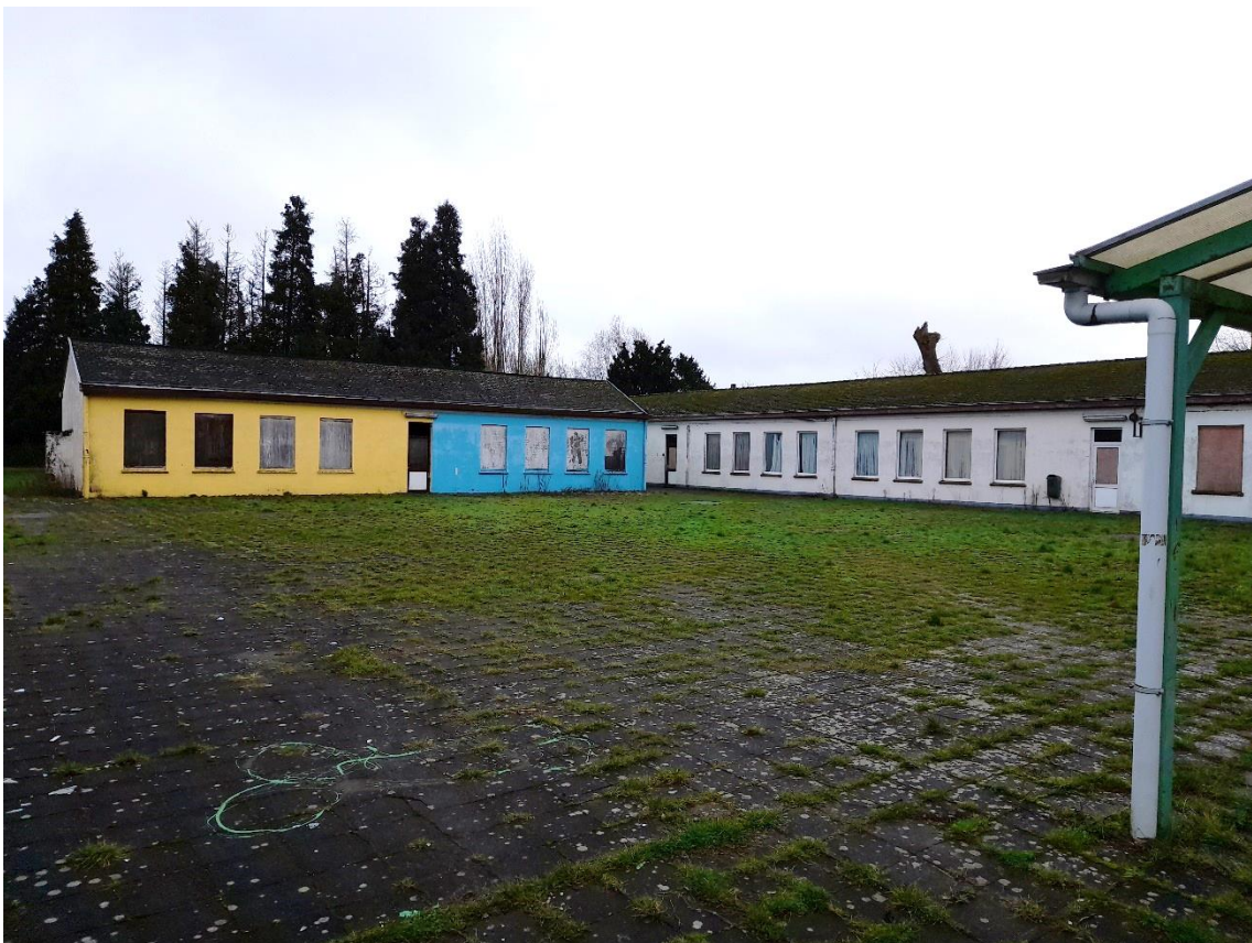
Figuur 13: Foto 8 bestaande toestand
