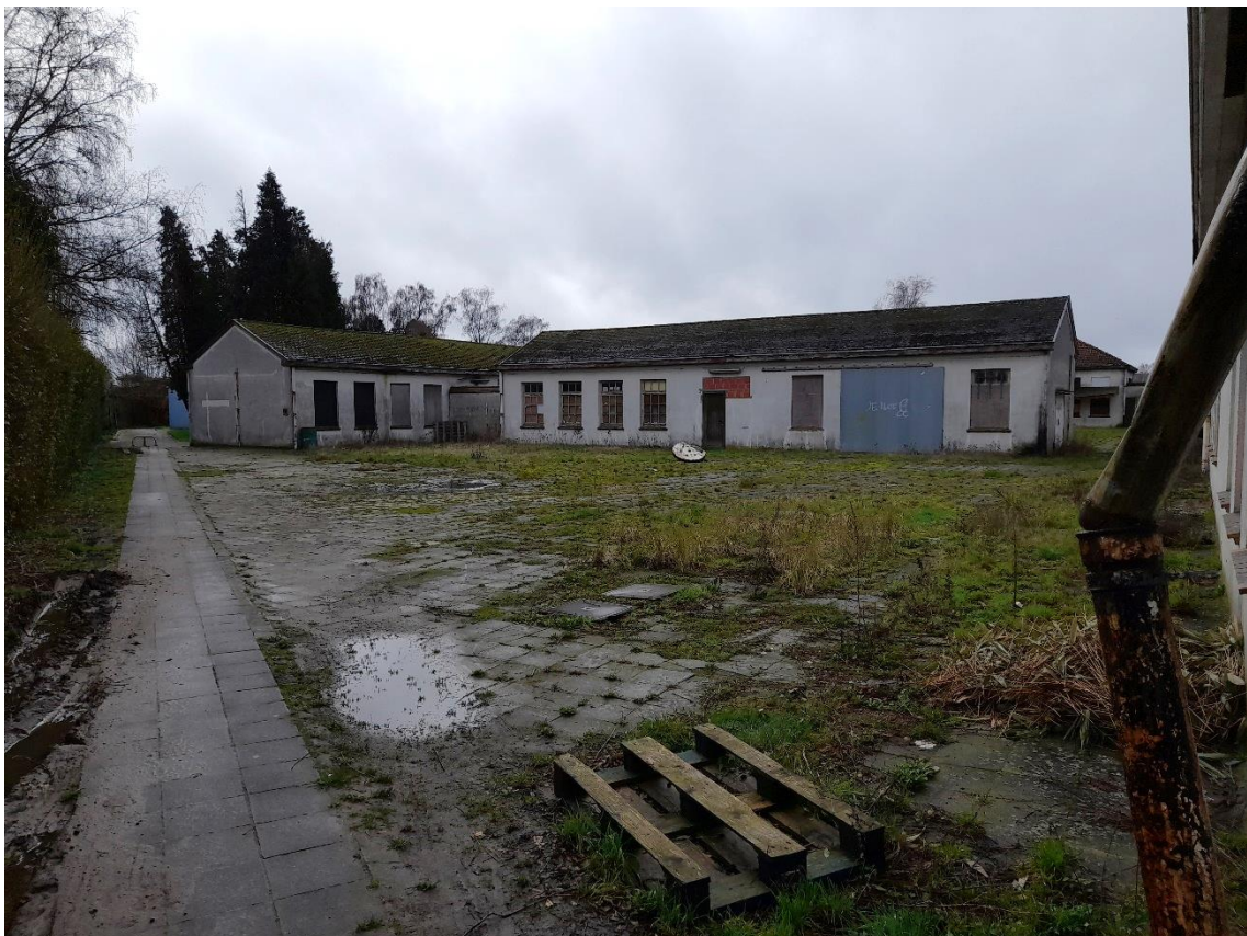
Figuur 9: Foto 4 bestaande toestand
