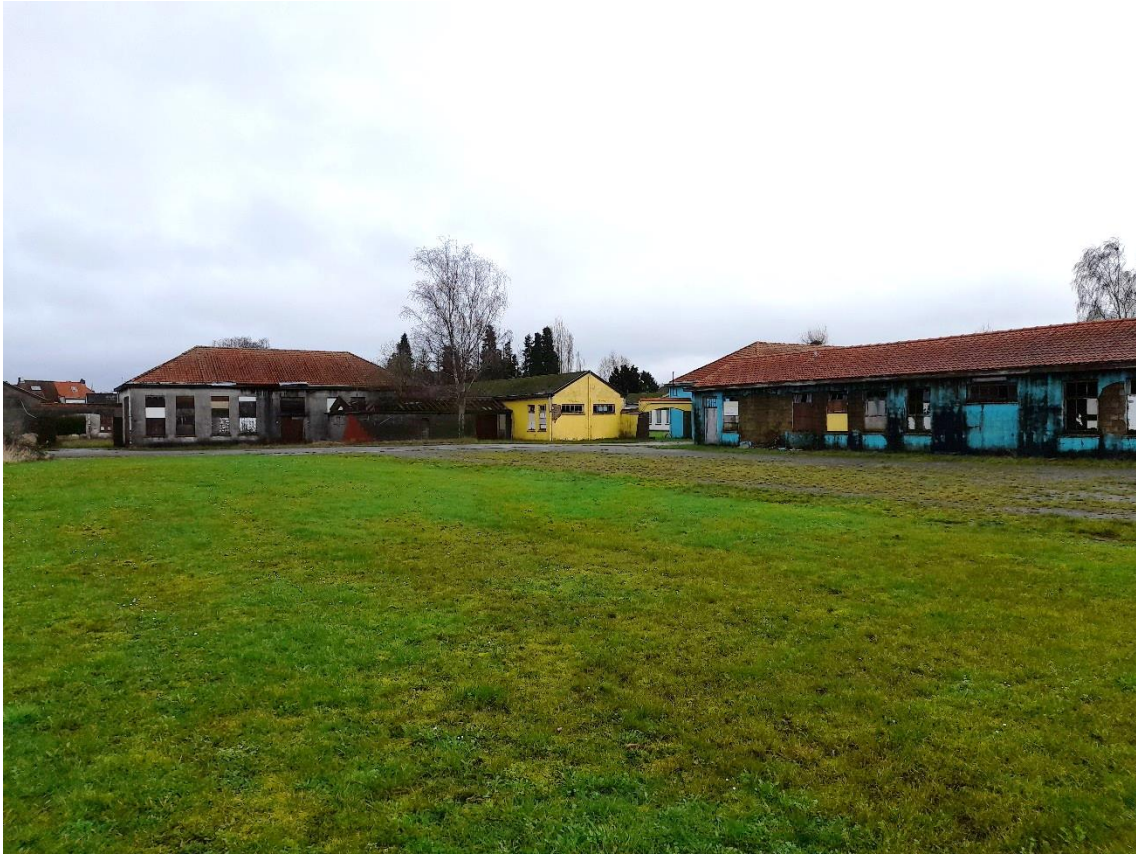
Figuur 12: Foto 7 bestaande toestand
