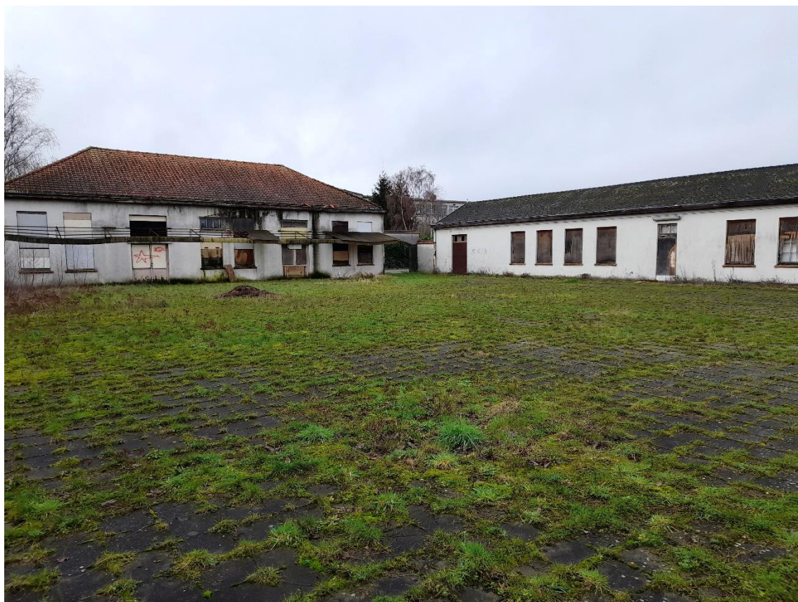
Figuur 10: Foto 5 bestaande toestand
