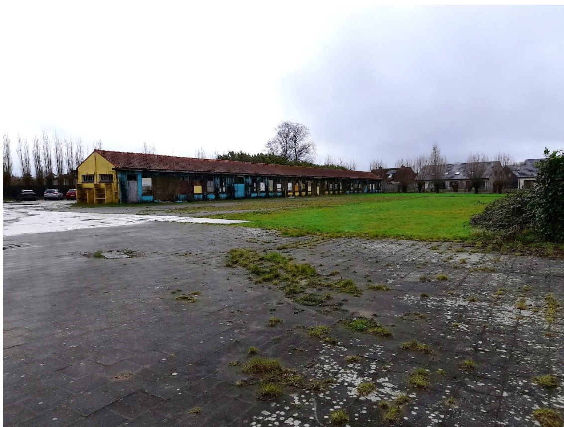
Figuur 11: Foto 6 bestaande toestand
