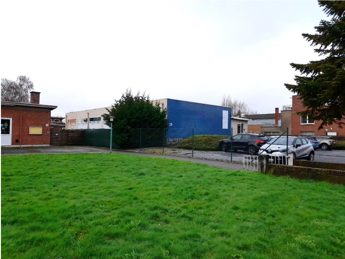
Figuur 16: Foto 11 bestaande toestand
