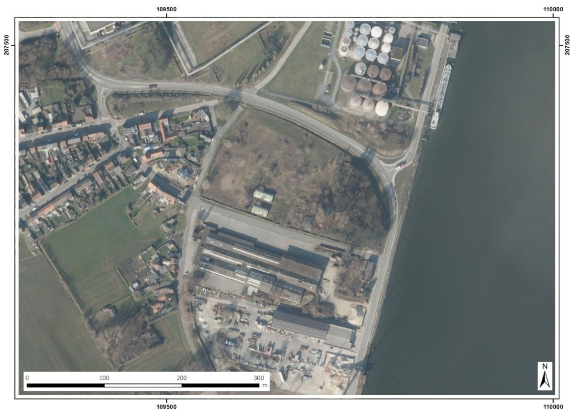
3 Luchtfoto 2021 voor sloop fabrieksgebouw © AIV.
