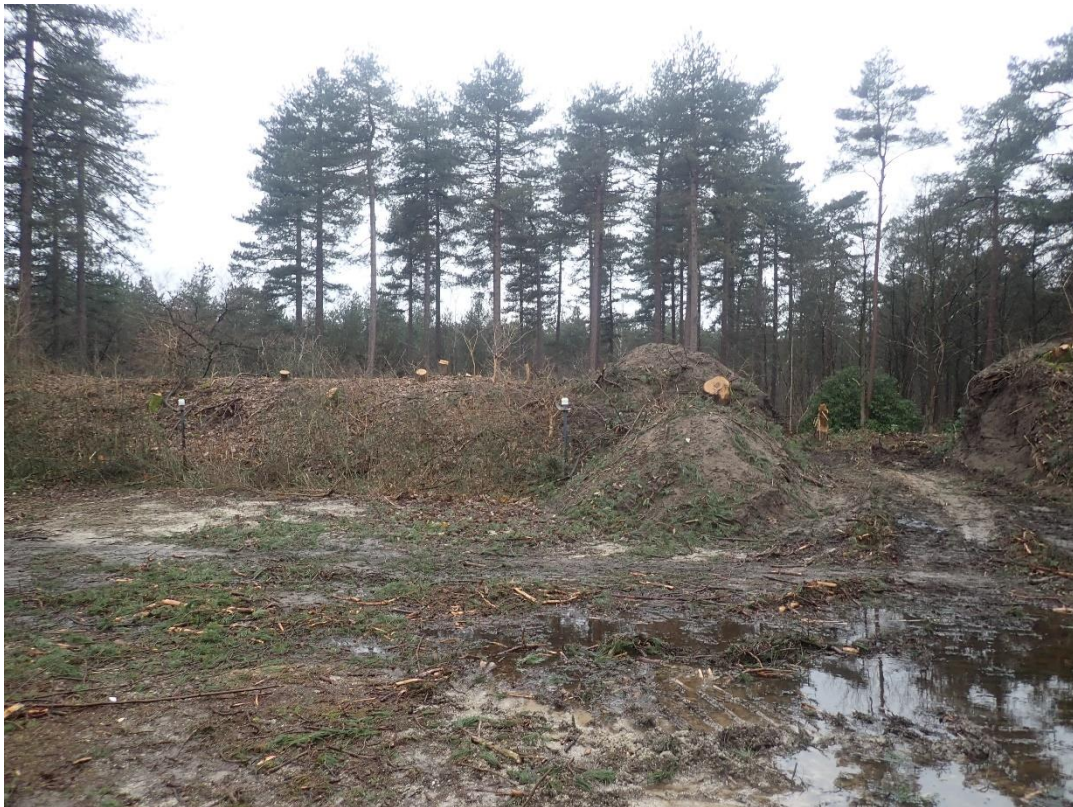
Figuur 33: Zicht op de aarden talud met doorgang voor de kraan
