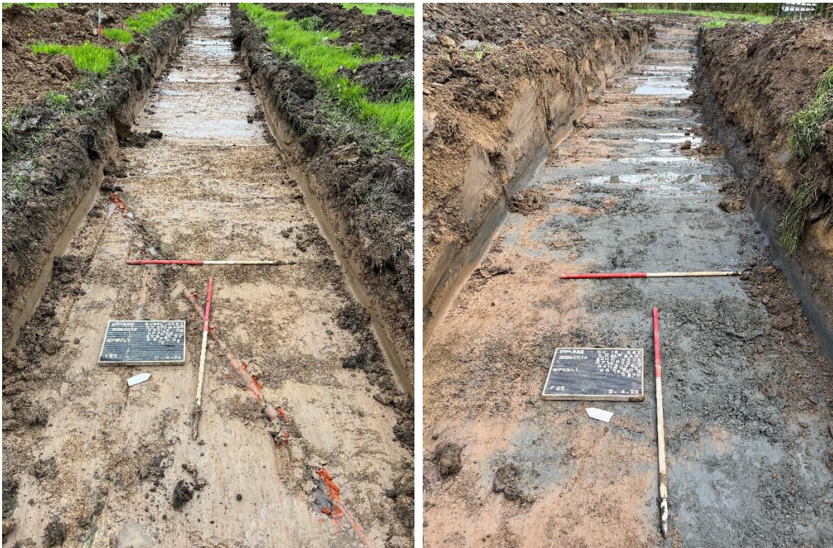
Figuur 79. Voorbeeld van een drainagebuis in werkput 16 (links) en reductievlekken in werkput 10 (rechts).
