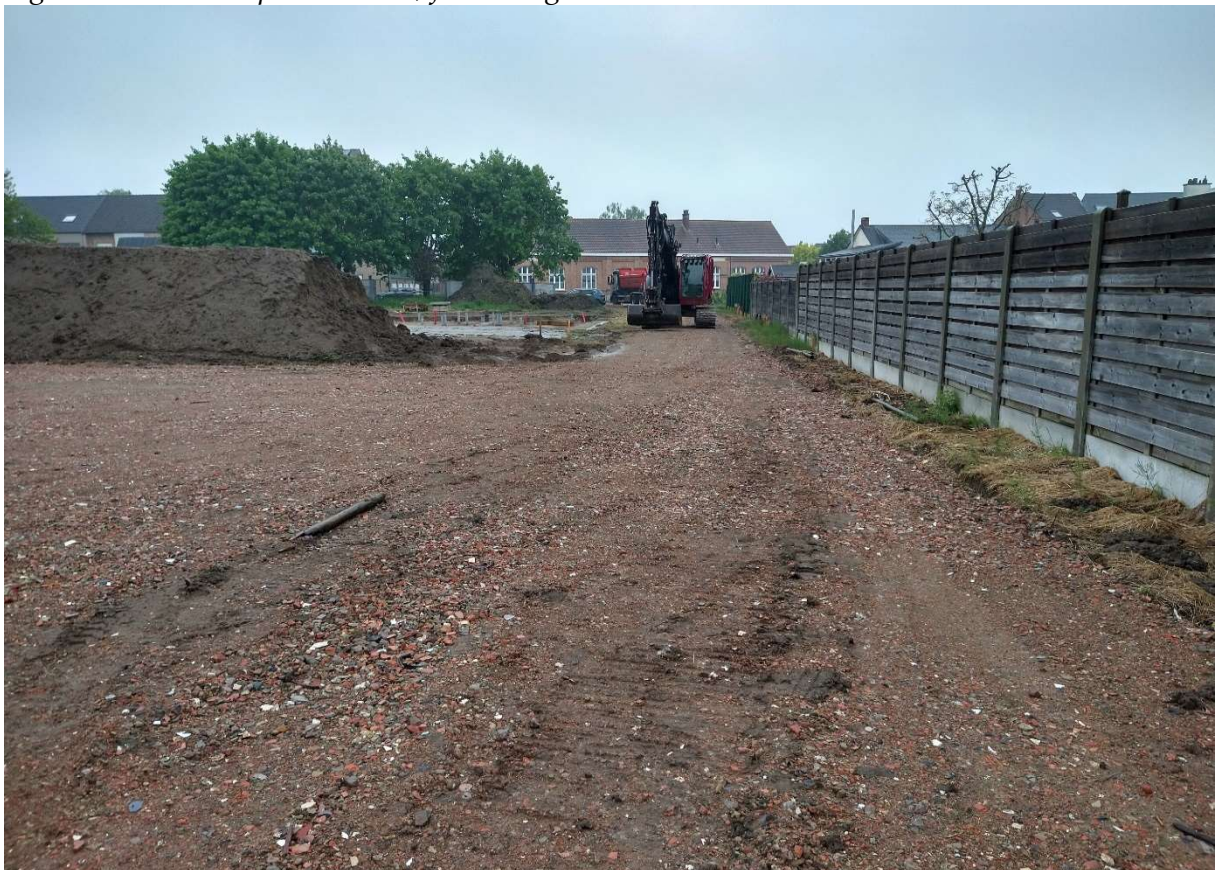
Figuur 12e. Zicht op het terrein, toegangszone in het noorden van het terrein. ©LARES
