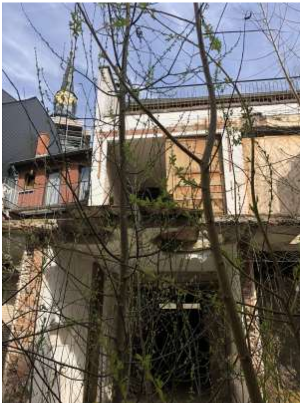
Afb. 21: overzicht achterzijde, gesloopt deel (Bron: initiatiefnemer, Fotografisch Verslag BIJLAGE 11)
