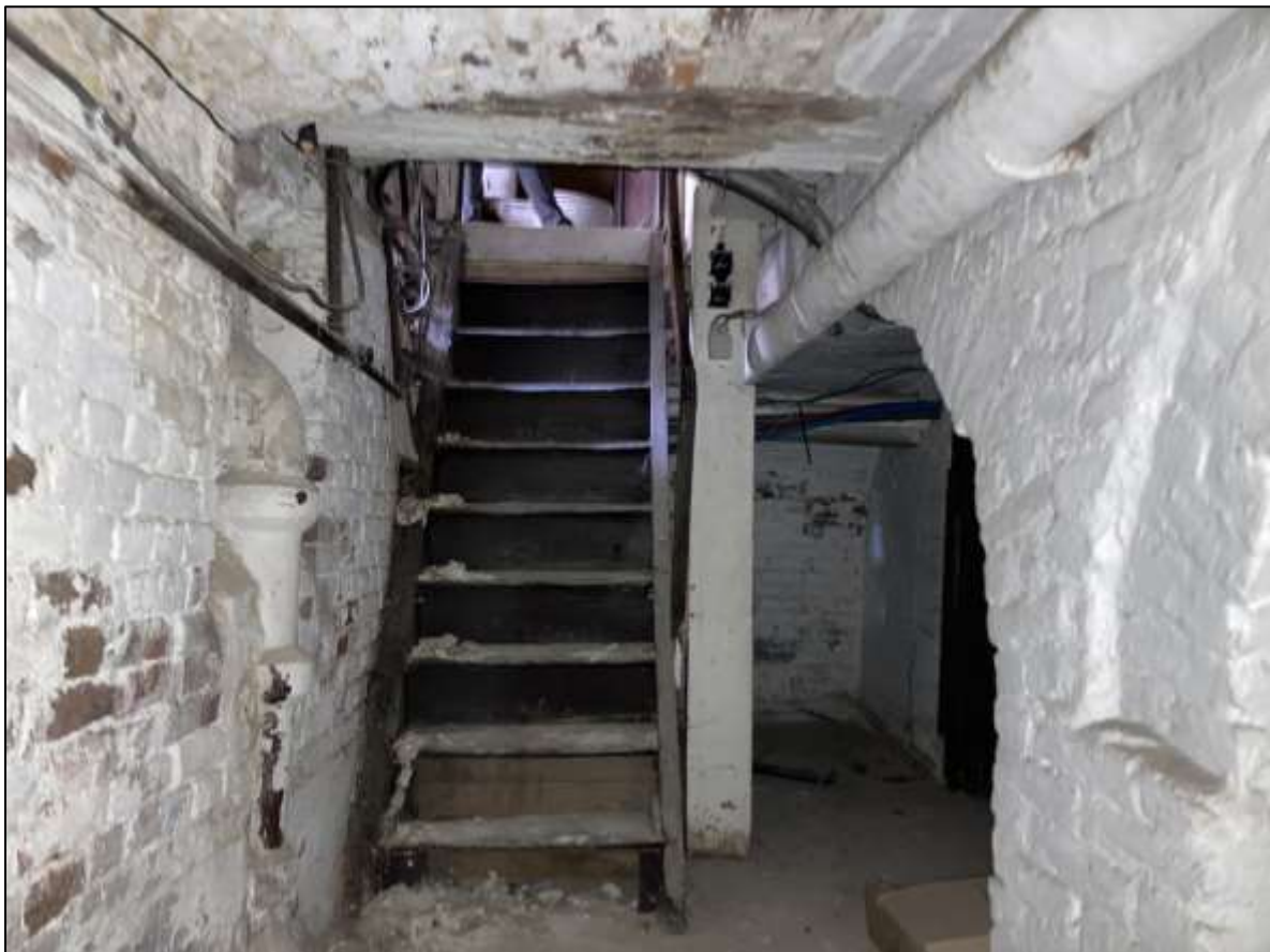
Afb. 19: zuidzijde van de kelder (Bron: C&C Fexer bv 2023, Afb.17)
