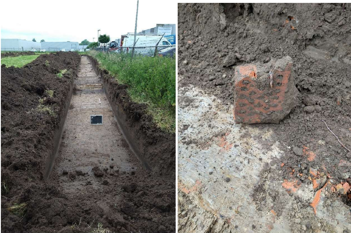
Figuur 11b. Zicht op sleuven WP5 en detail van de snelbouwsteen. ©LARES
