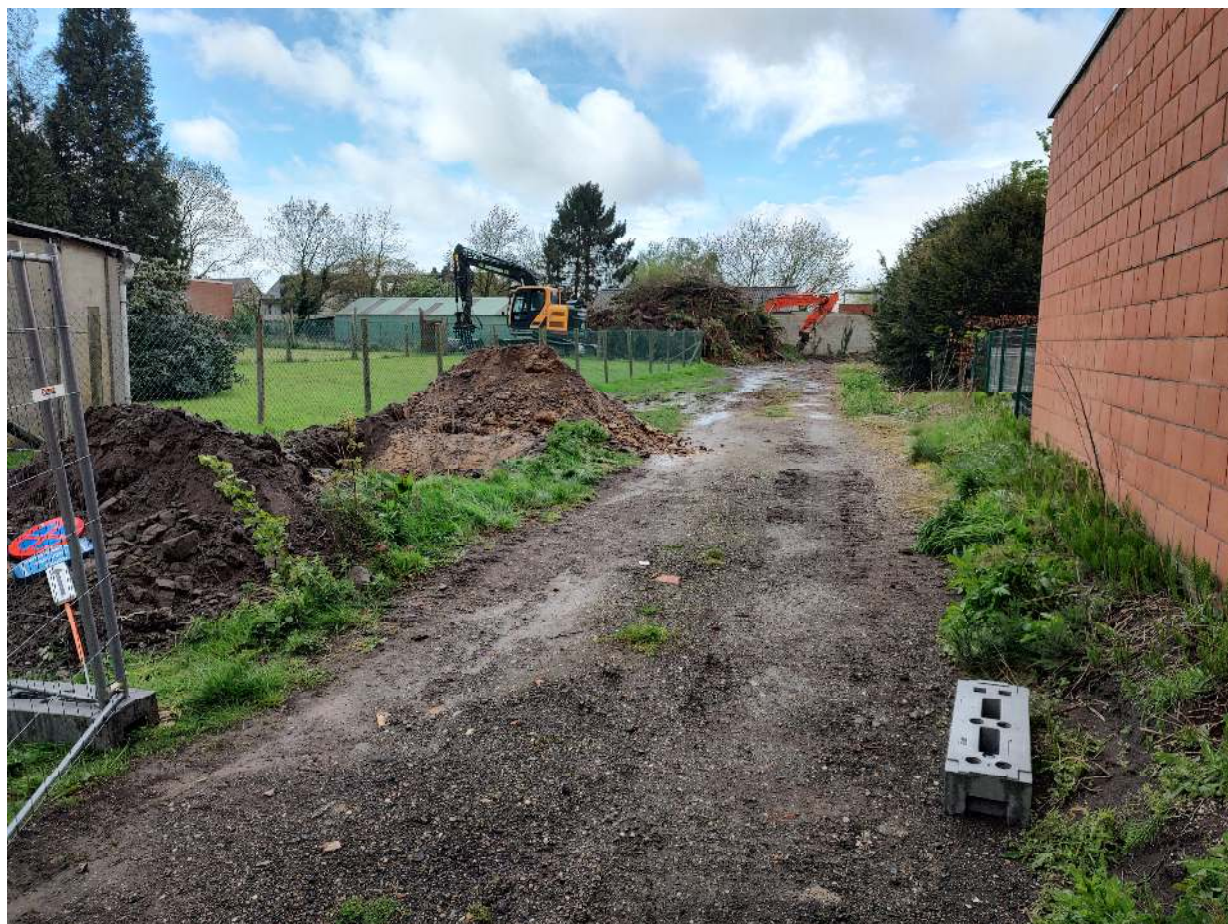
Afbeelding 7.4.2.4: Impressie van het plangebied ter hoogte van de toegangsweg. Links kan werkput 1 worden herkend. Net voor de heras bekken stond vroeger een garage en kon duidelijk een afgraving worden herkend. Op de achtergrond zien we de grote hoop met takken en stammen met daarnaast de graafmachine van de ontbosser.
