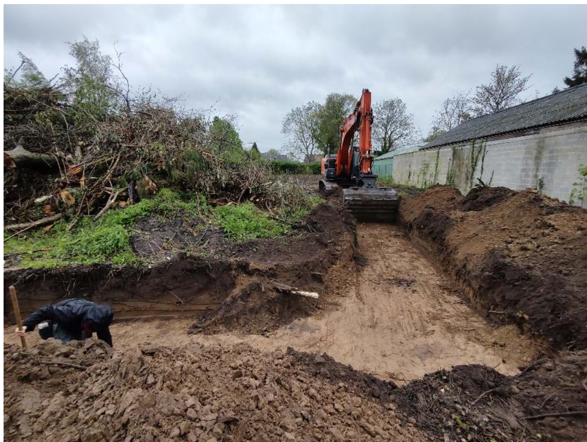
Afbeelding 7.4.2.1: Werkput 2 werd aangelegd met een knik zodat er gedeeltelijk omheen de hoop met takken en stammen kon worden gewerkt, zonder dat het onmogelijk wordt om deze in de toekomst af te voeren.
