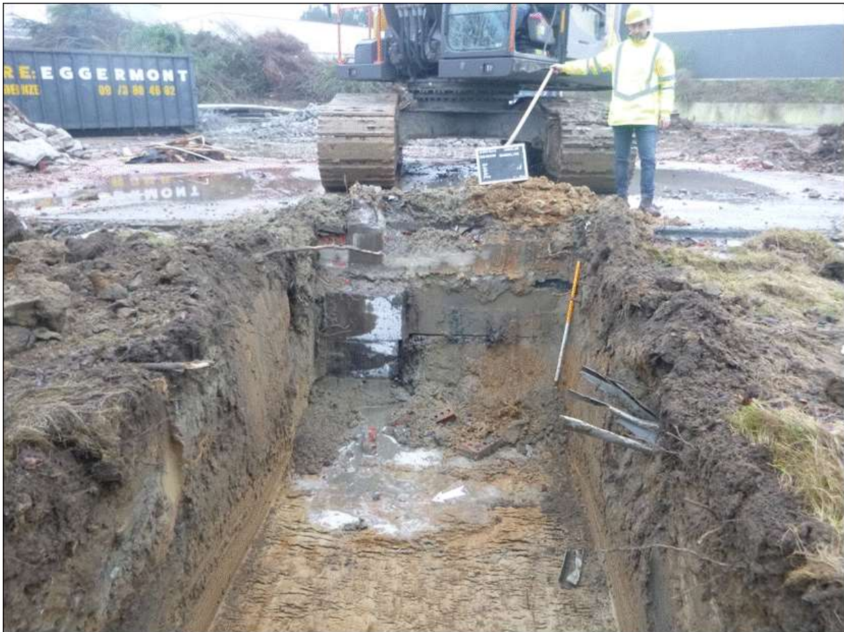
Figuur 13: Foto genomen aan de rand van PR3 met zicht op de oostelijke rand waar de funderingen nog aanwezig zijn (ABO nv 2024).
