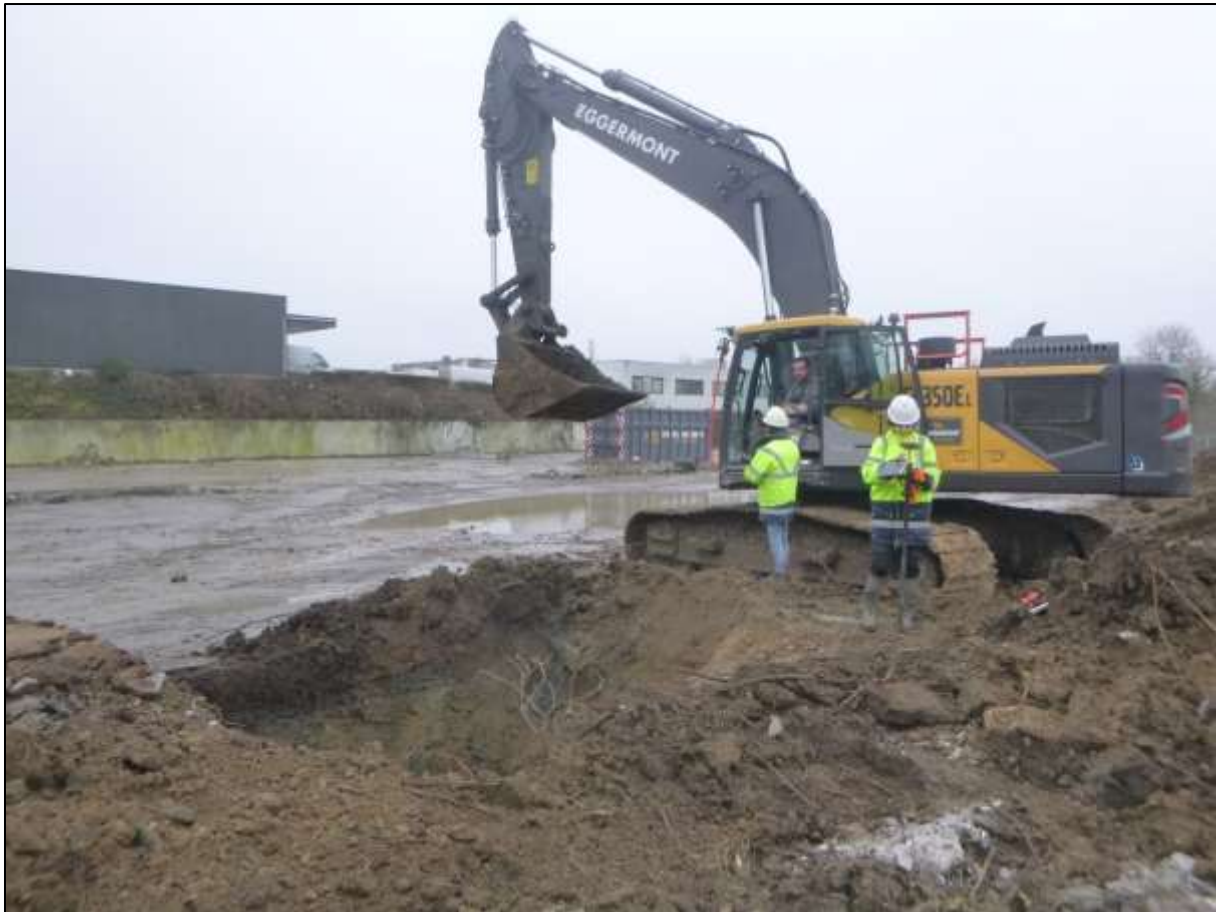
Figuur 7: Foto genomen tijdens de aanleg van profielput 4 in de onderzoekzone langs de Engelse Wandeling 11-13 te Kortrijk (ABO nv 2024)
