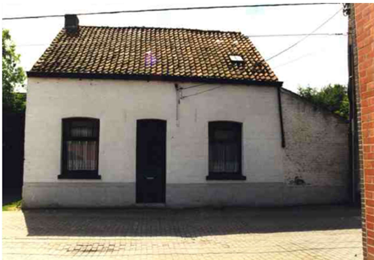
Figuur 2. Reeds gesloopt dorpshuis. ©INVENTARIS BOUWKUNDIG ERFGOED
