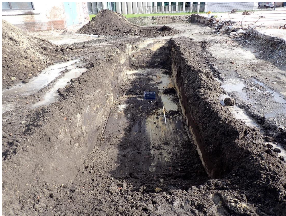
Figuur 22: Zicht op het noordelijke deel van werkput 1 vanuit het zuiden. Deze werkput was verstoord tot op een diepte van ca. 2 m -mV. De wanden waren onstabiel en stortten in enkele ogenblikken na het maken van de linkse foto. Uit veiligheidsoverwegingen werd deze werkput niet betreden. (ARCHEBO bvba, 2024)
