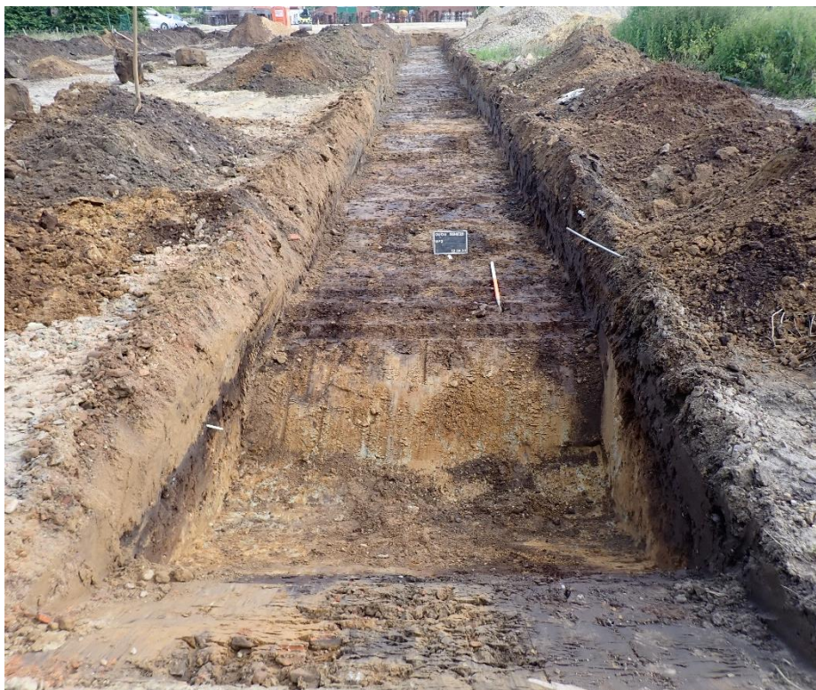
Figuur 30: Zicht op de verstoringen en betonblokken van werkput 1 vanuit het noorden (ARCHEBO bv, 2024)
