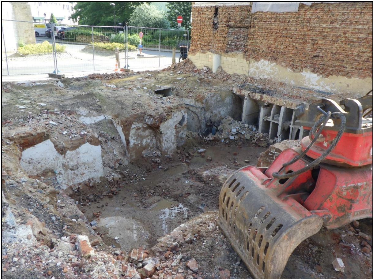
Figuur 9 Zicht op de kelder aan de straatzijde.
