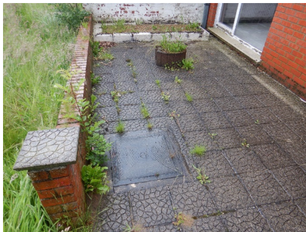
Figuur 7. Zicht op de terrassen van de achtertuinen. Onder: putdeksel wijzend op de aanwezigheid van een beerput.
