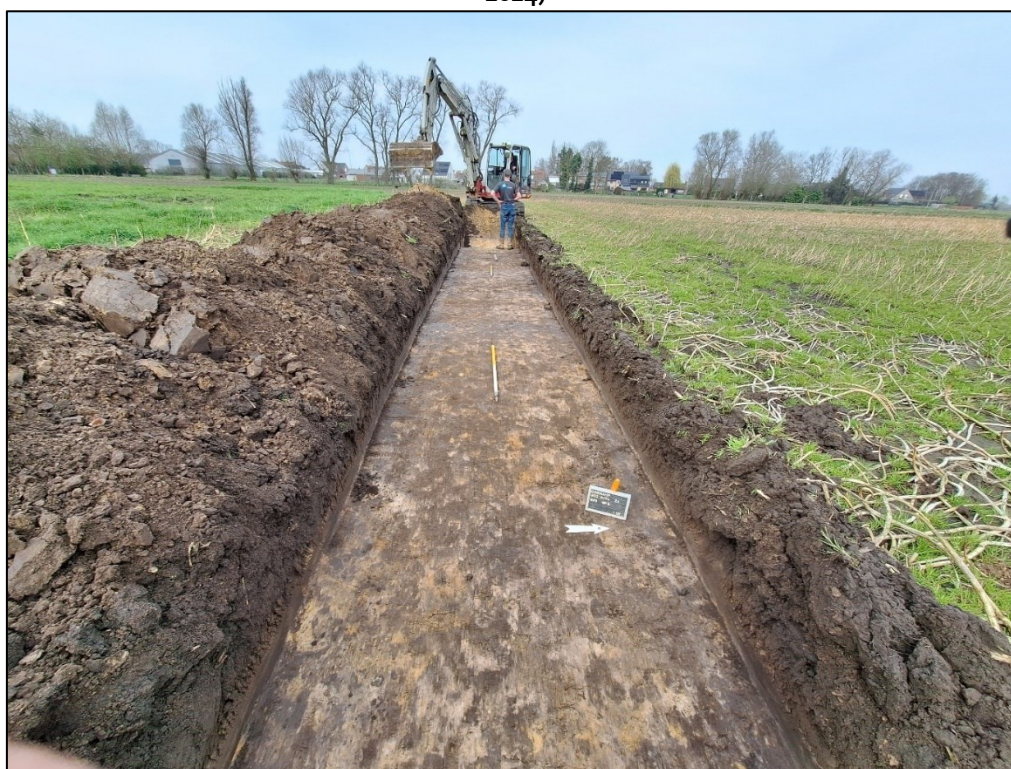
Figuur 86: Aanleg van werkput 3 voorbij het kijkvenster/sporenconcentratie in westelijk richting in zone 4 (ABO nv 2024)
