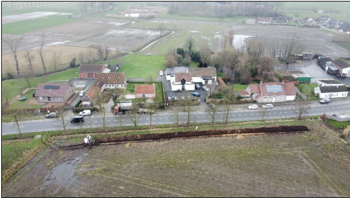
Figuur 97: Overzichtsfoto zone 8 tijdens het proefsleuvenonderzoek (ABO nv 2024)
