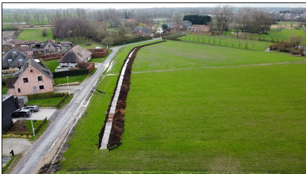
Figuur 91: Overzichtsfoto zone 5, werkput 1 (ABO nv 2024)
