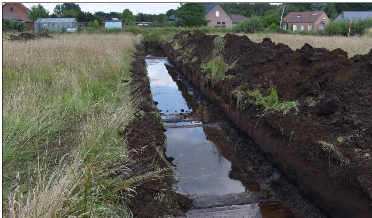
Afb. 35: Werkfoto van het noordelijke gedeelte van SL4, foto genomen vanuit het zuiden een uur na aanleg van de sleuf.
