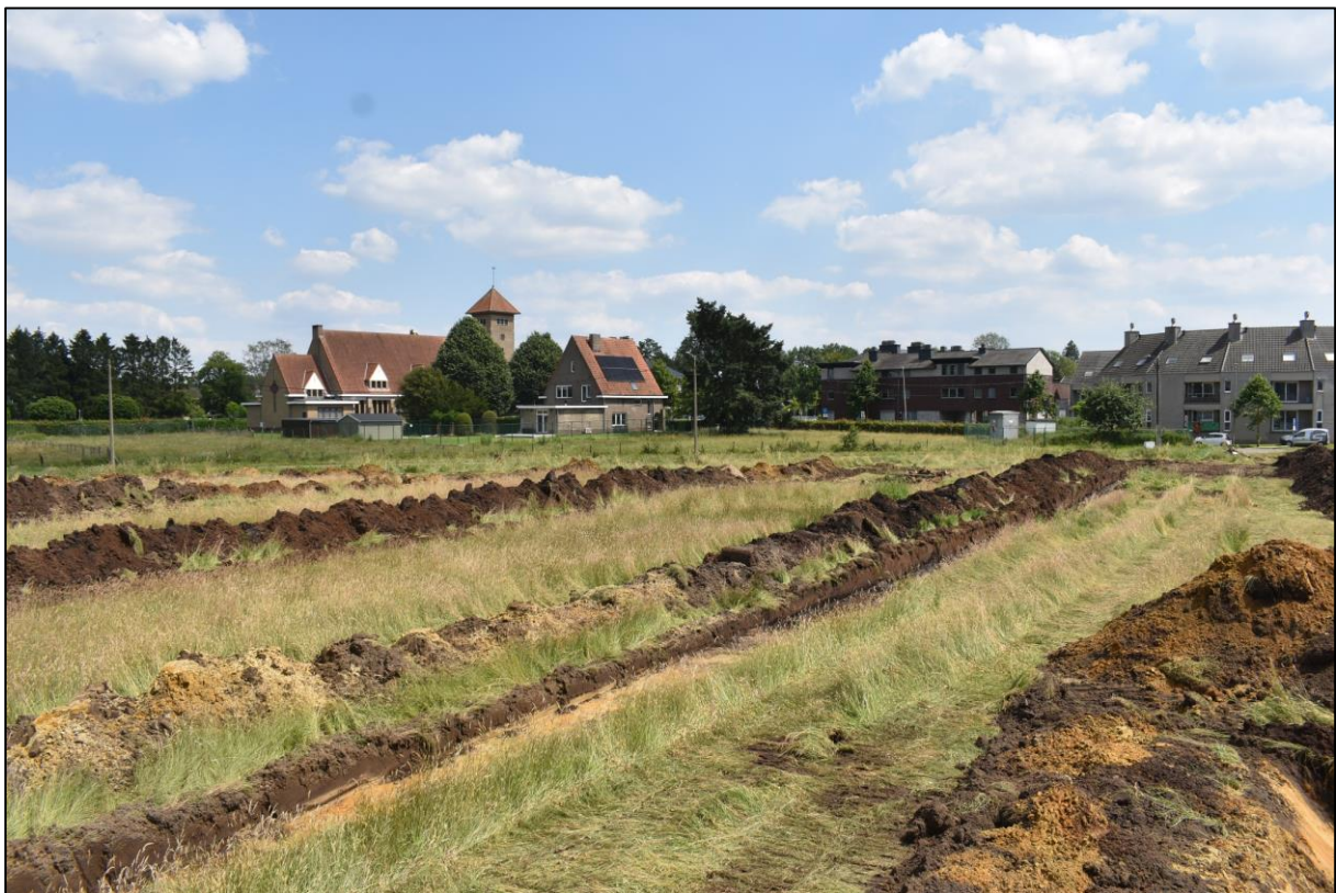
Afb. 26: Overzichtsfoto van de aangelegde sleuven vanuit het noordwesten.
