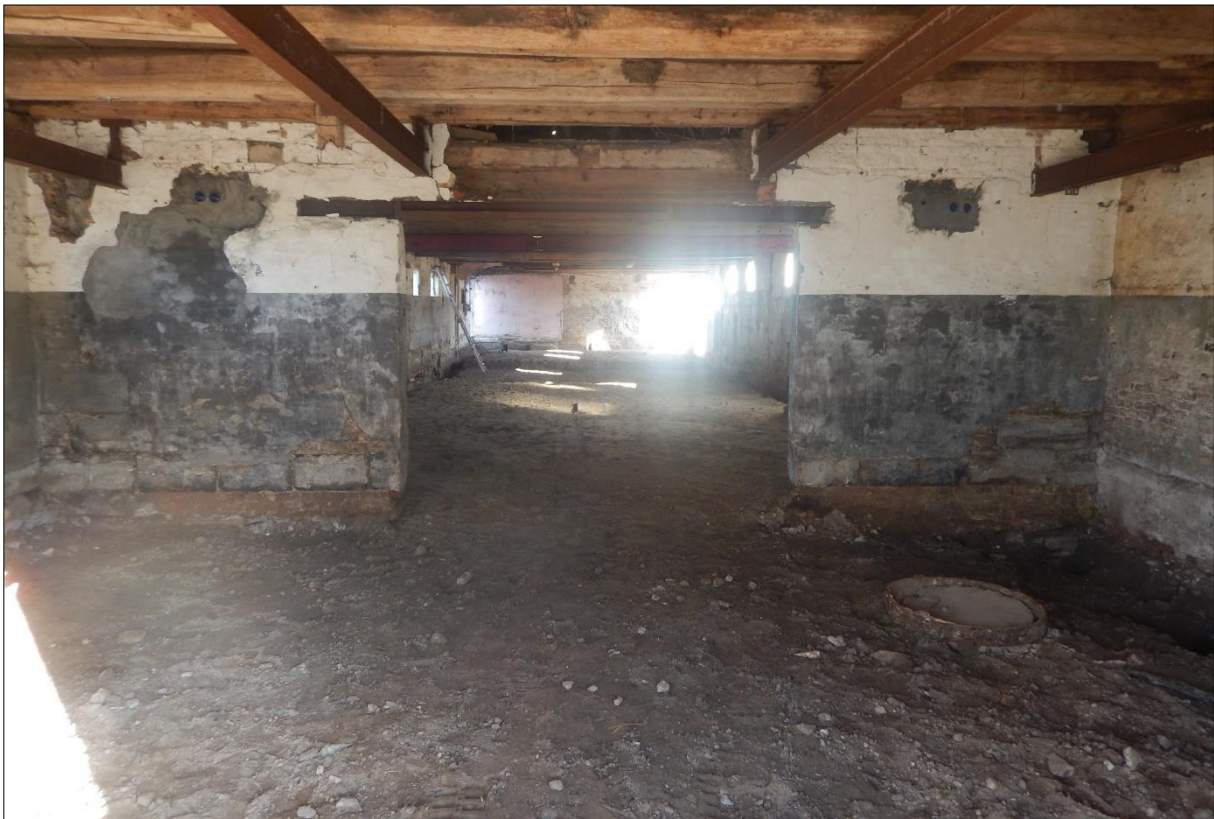
Figuur 9: Locatie proefputten 2 & 4 in het hoevegebouw (zicht vanuit het oosten)
