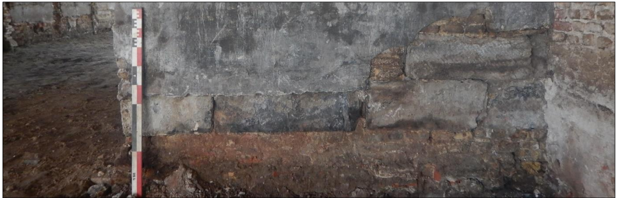
Figuur 26: Het oorspronkelijk vloerniveau = onderkant natuursteen
