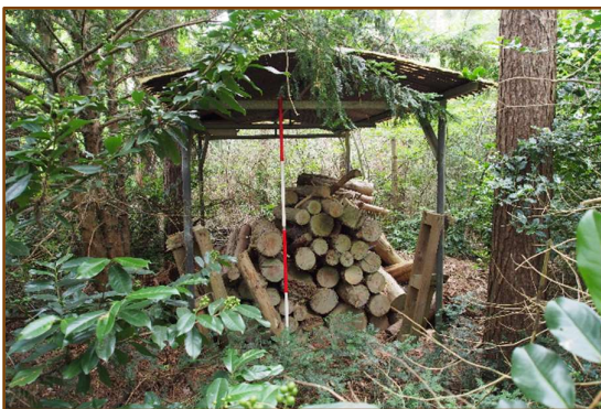
Figuur 30: Niet gefundeerd afdak (foto AIR)
