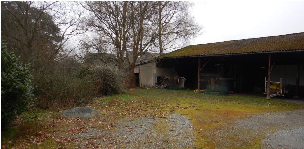
Figuur 9. De zuidoostelijke hoek van het terrein.
