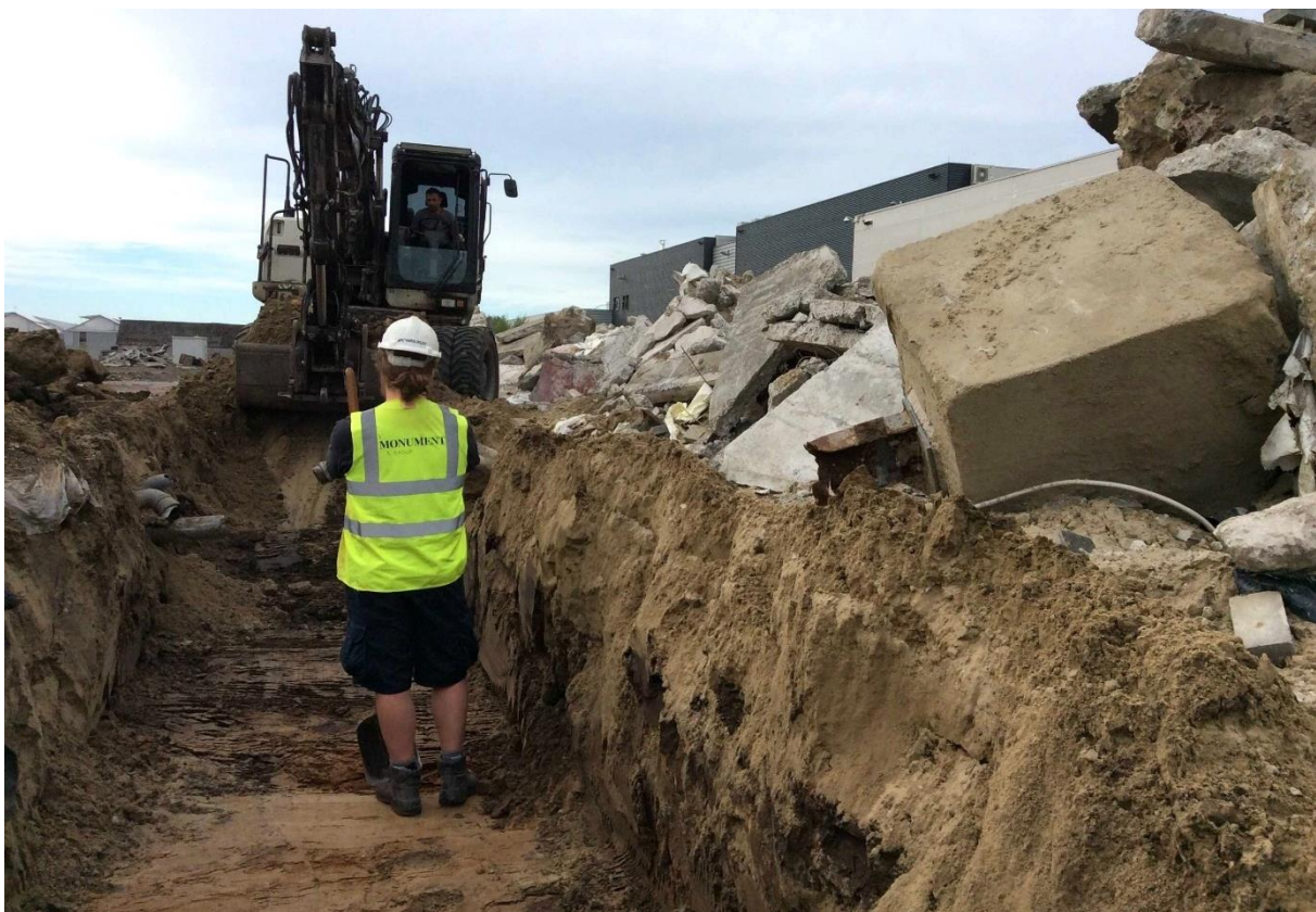
Figuur 25: Het uitgraven van proefsleuf 4 naast het aanwezige betonpuin.
