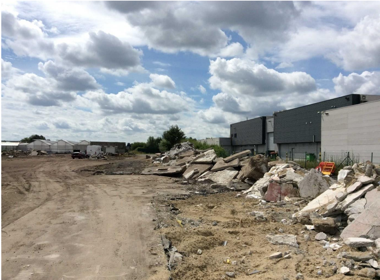
Figuur 4: Werfweg bestaand uit een restant van de betonplaten (links) en een langgerekte strook betonpuin.
