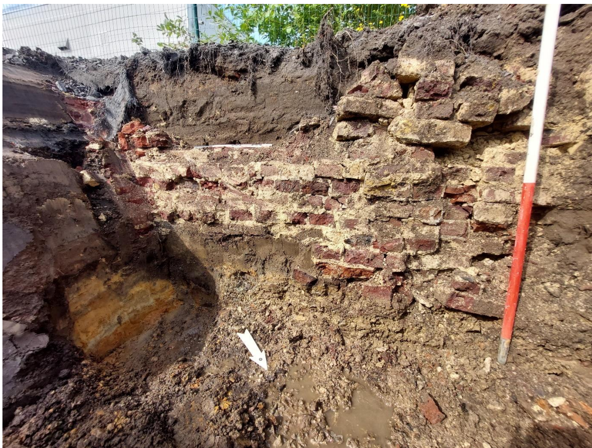
Figuur 43: Een muur in de wand van proefsleuf 6 kan gelinkt worden aan de recent gesloopte structuren en is als dusdanig als versterking geïnterpreteerd. Daaronder bevindt zich plaatselijk wat C-horizont (linksonder).
