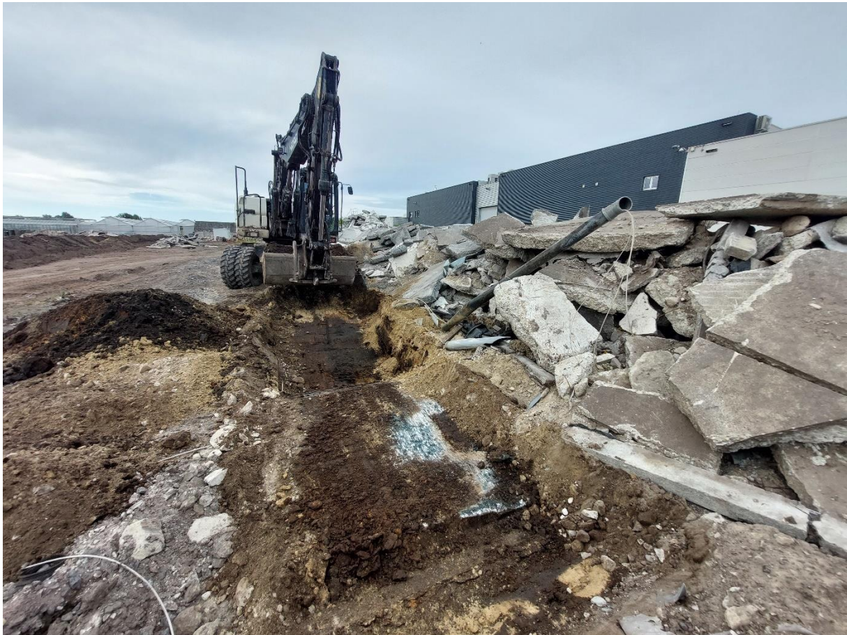
Figuur 26: Restant van betonmassief (voorgond) ter hoogte van proefsleuf 4 en het aanwezige puin.
