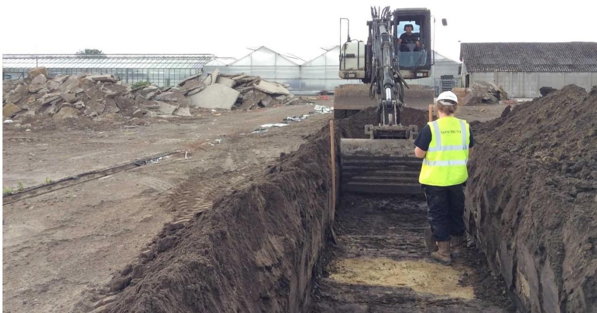
Figuur 27: Het uitgraven van proefsleuf 2.
