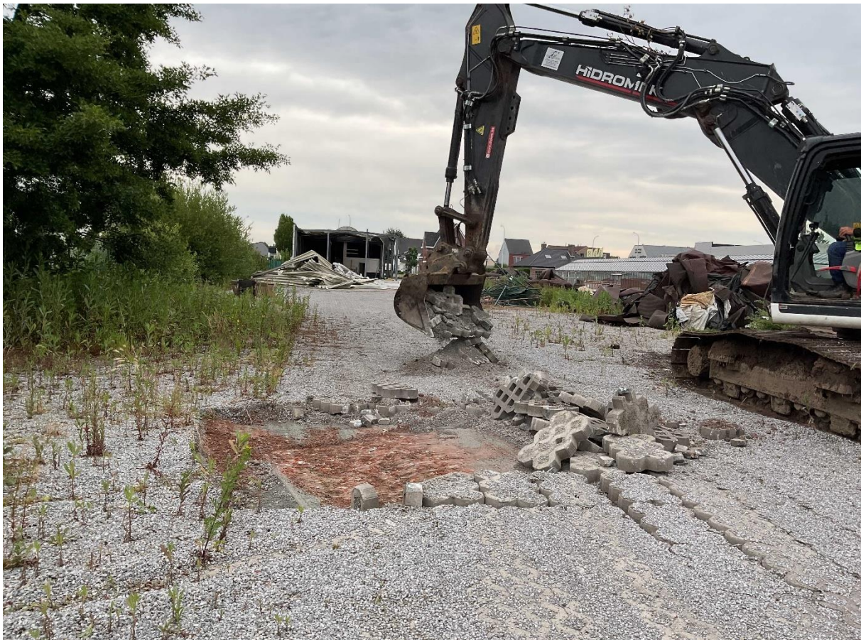
Figuur 8: Het plaatselijk verwijderen van de verharding in het zuiden van het projectgebied ter hoogte van profielput 5 in functie van het plaatsen van profielput 5 (© Monument Vandekerckhove nv).
