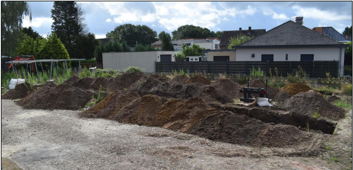
Afb. 24: Zicht op het westelijke deel van SL1 & SL2
