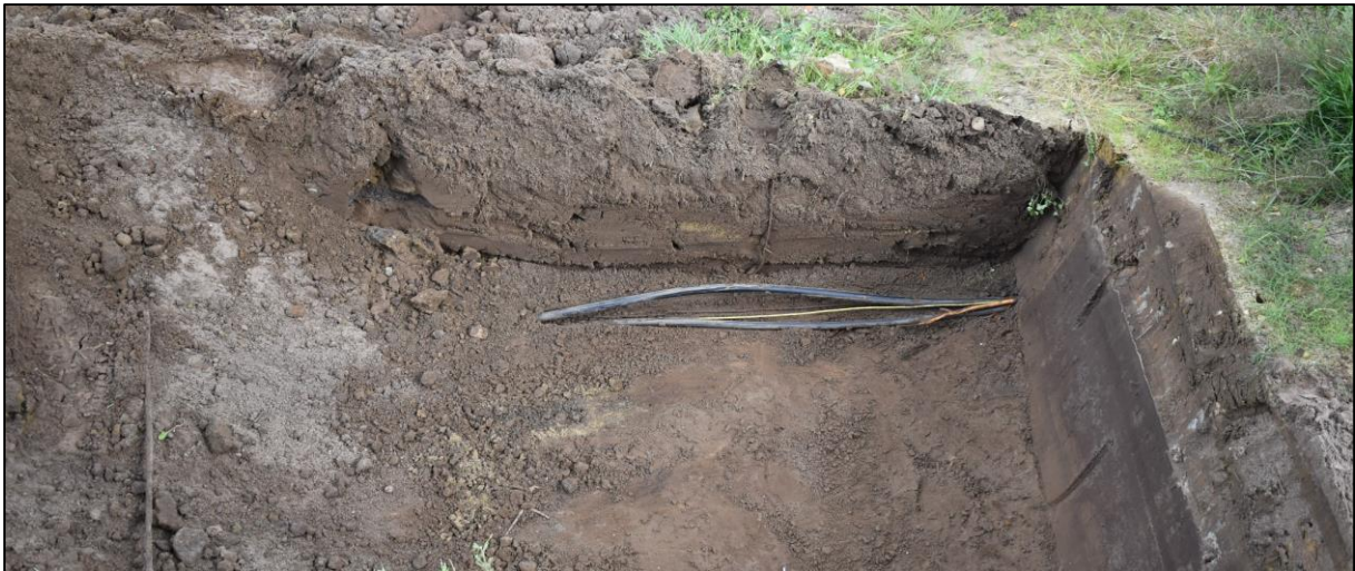
Afb. 20: Nutsleiding in het oostelijke deel van SL2.
