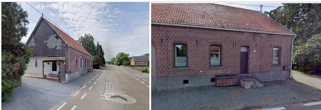
Figuur 7: Woonhuis nummer 25-27, let op de kelderramen in de rechterfoto (Google Street View, juli 2023)
