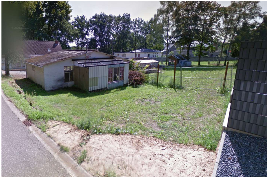
Fig. 2.9: Zicht op het terrein voor de afbraakwerken.
