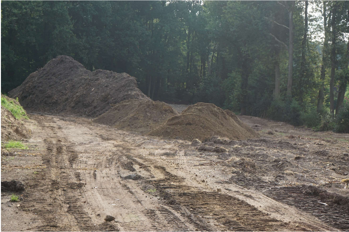
Fig. 3.10: Zicht op de grondhopen centraal op het terrein.
