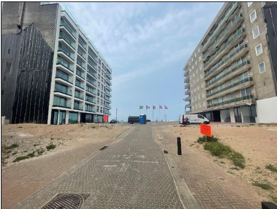
Figuur 1: Zicht op de parking vanuit het zuiden. 4
