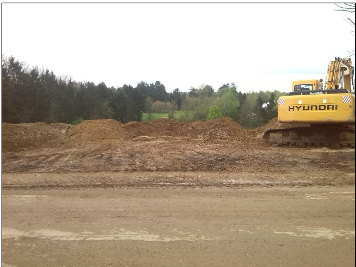
Figuur 5: Zicht op de huidige situatie van het terrein voor grondverbetering als gevolg van de werken in het kader van project TRV3003. (Bron: Opdrachtgever, foto genomen op 18 april 2017 vanuit Jezus Eiklaan)
