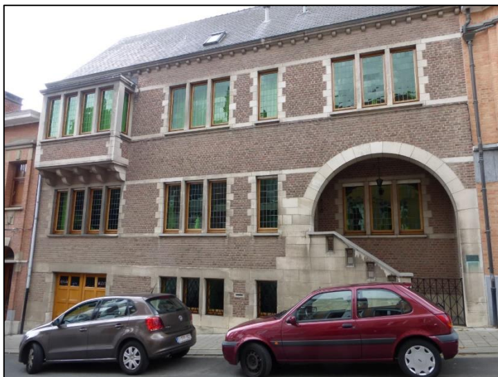
Figuur 28: Sociale huisvesting met ID 301602 (boven), Gemeentelijke basisschool Tervuren Centrum met ID 216929 (midden) en dokterswoning met ID 300092 (onder). (Bron: Inventaris Onroerend Erfgoed 2017)
