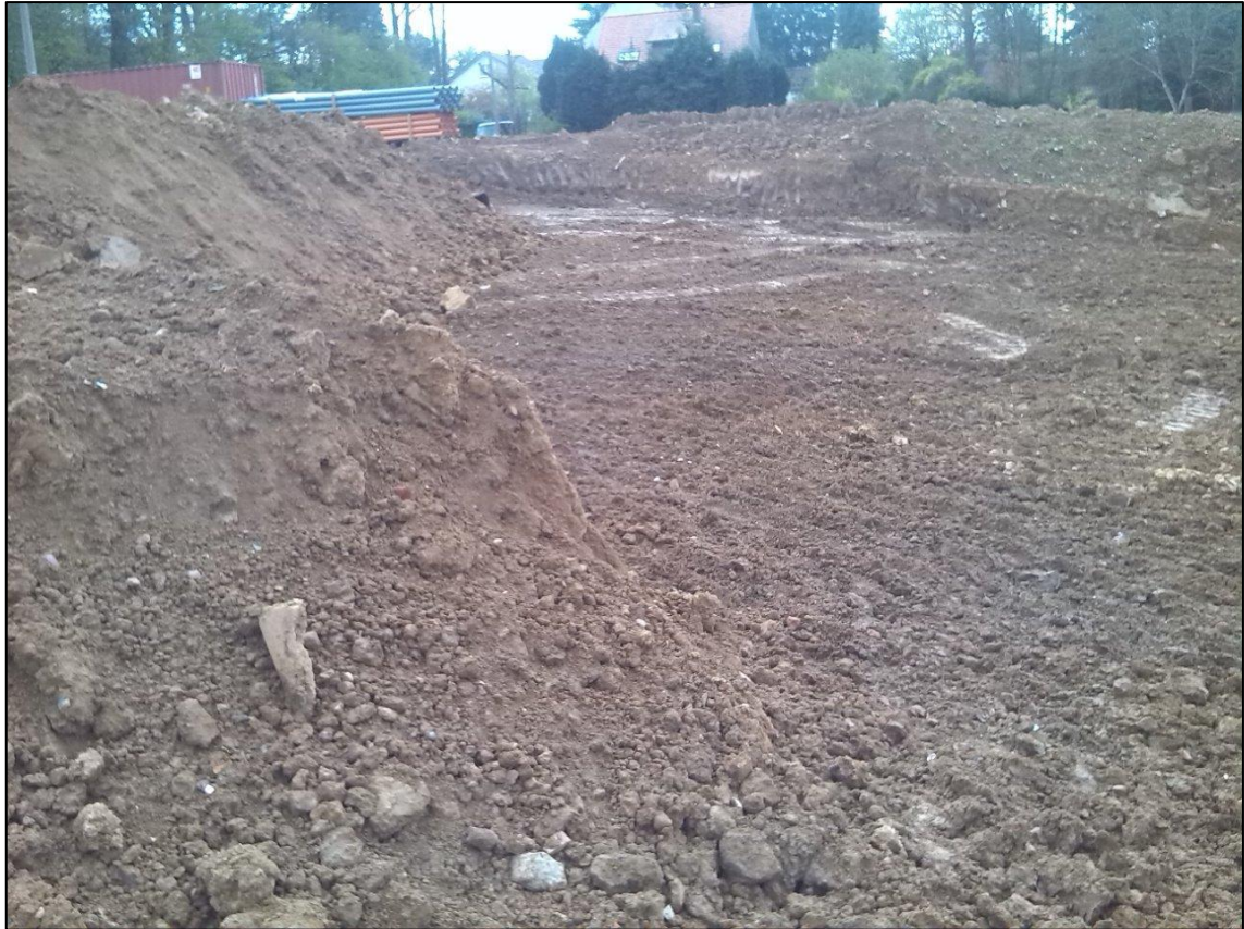
Figuur 6: Zicht op de huidige situatie van het terrein voor grondverbetering als gevolg van de werken in het kader van project TRV3003. (Bron: Opdrachtgever, foto genomen op 18 april 2017 vanop het terrein in richting van de Jezus Eiklaan)
