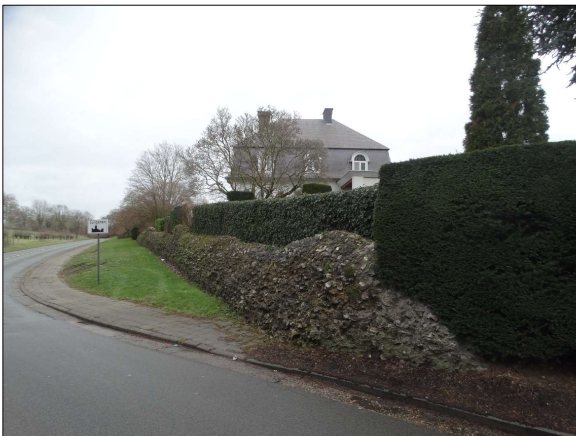
Afb. 9: Zicht op het projectgebied vanaf het kruispunt met en langs de Legioenelaan. Op de voorgrond de als monument beschermde Romeinse stadsmuur (Foto: stad Tongeren).
