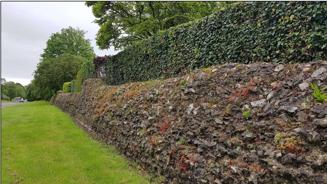
Afb. 47: Buitenzijde van de Romeinse stadsmuur, net buiten het onderzoeksgebied, achter de haag.
