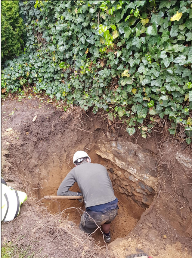
Afb. 46: Aanleg van de proefput in het noorden van de tuin tegen de Romeinse muur (achter de haag).
