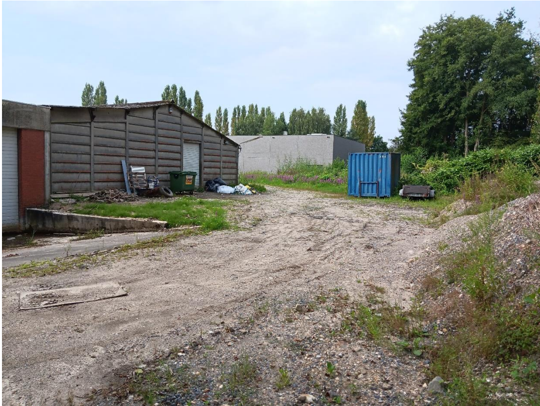
Figuur 6: Actuele situatie achter de gebouwen, ter hoogte van BP6 richting BP7.
