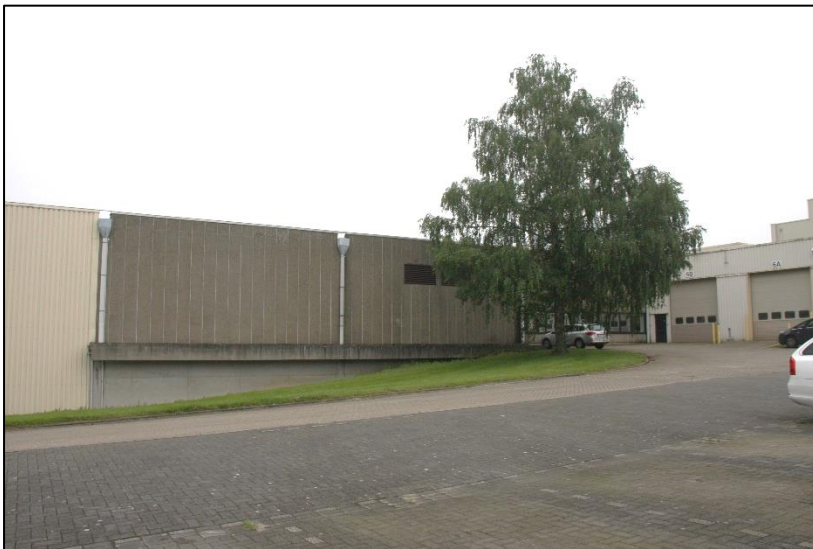
Afb. 16: FOTO 9, Zicht in de richting van gebouw B vanop de personeelsparking in het westen. Met uitzondering van enkele graspartijen is het merendeel van het terrein verhard. Foto genomen uit het noordwesten (Aron bvba, dd 01/06/2016)
