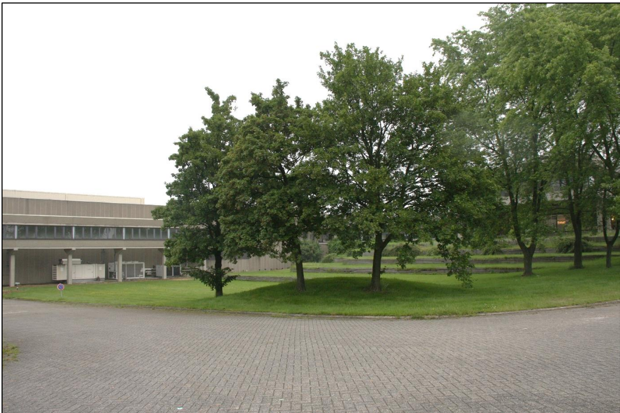
Afb. 19: FOTO 12, Zicht op gebouw B (links) en gebouw A (achteraan achter de bomen). Het terrein loopt hier terug naar hetzelfde niveau als in het oosten. Een vijver bevond zich eertijds achter deze bomen. Foto genomen uit het zuidwesten (Aron bvba, dd 01/06/2016)
