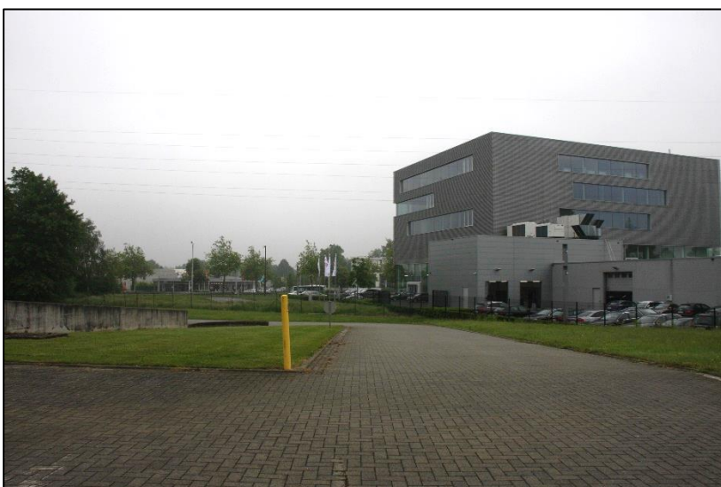
Afb. 17: FOTO 10, Zicht in de richting van de bedrijfsgebouwen van de autogarage Delorge die zich ten westen van het terrein situeren. De ophoging daalt hier terug in de richting van de Herkenrodesingel. Foto genomen uit het noorden (Aron bvba, dd 01/06/2016)
