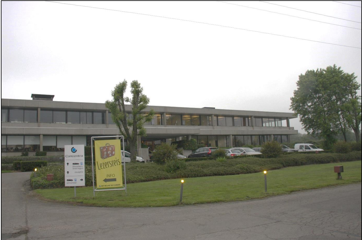
Afb. 8: FOTO 1, Zicht op blok A, met vooraan de bezoekersparking. Het terrein stijgt in de richting van dit blok. Met uitzondering van enkele graspartijen is het merendeel van het terrein verhard. Foto genomen uit het zuid-zuidwesten (Aron bvba, dd 01/06/2016)
