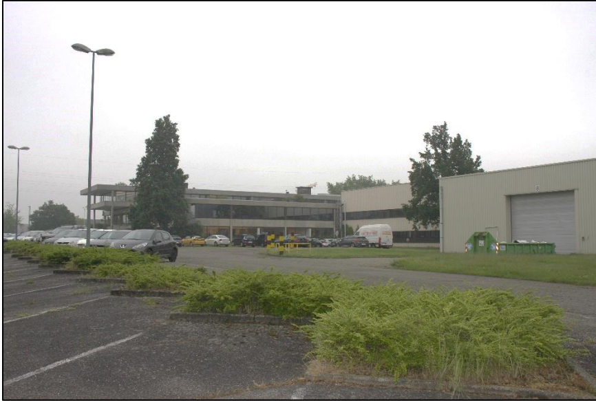
Afb. 10: FOTO 3, Zicht op gebouw B (rechts vooraan en centraal), en het A-gebouw (achteraan). Links is de personeelsparking zichtbaar die, met uitzondering van enkele plantenbakken, volledig verhard is. Op deze parking zijn bovendien verschillende afvoerputten zichtbaar. Foto genomen uit het noordoosten (Aron bvba, dd 01/06/2016)
