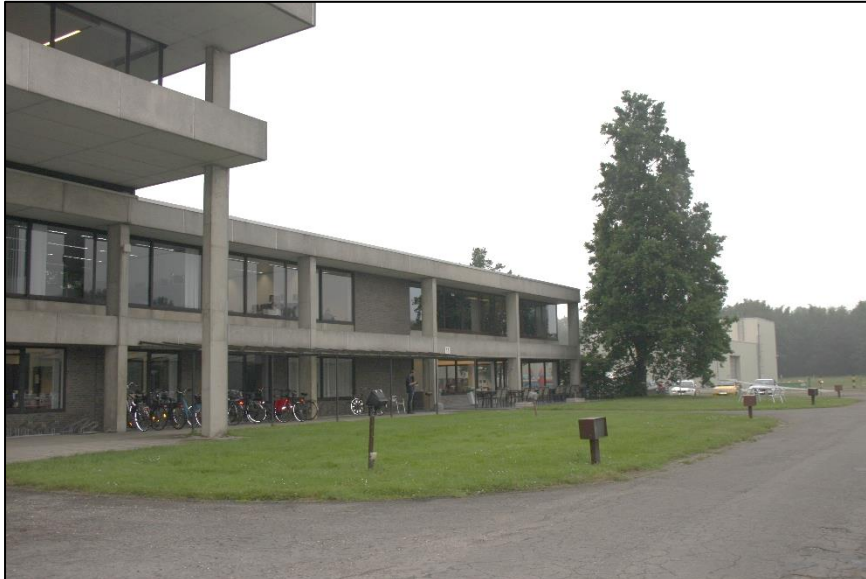
Afb. 9: FOTO 2, Zicht op gebouw A (vooraan), en gebouw B (helemaal achteraan). Foto genomen uit het zuidoosten (Aron bvba, dd 01/06/2016)
