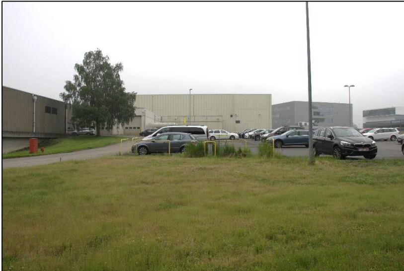
Afb. 15: FOTO 8, Zicht op personeelsparking in het westen van het terrein met links gebouw B en achteraan gebouw C. Deze zone is aanzienlijk hoger gelegen dan de rest van het terrein. Foto genomen uit het noorden (Aron bvba, dd 01/06/2016)
