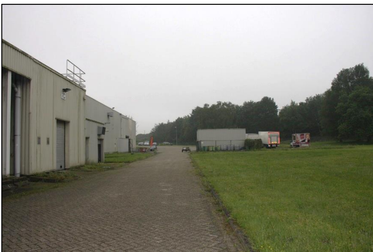
Afb. 14: FOTO 7, Zicht op de weg die gebouw B van het noordelijke grasland scheidt. Achteraan is de aanzet van de ophoging merkbaar die het westen van het terrein bepaald. Foto genomen uit het oosten (Aron bvba, dd 01/06/2016)
