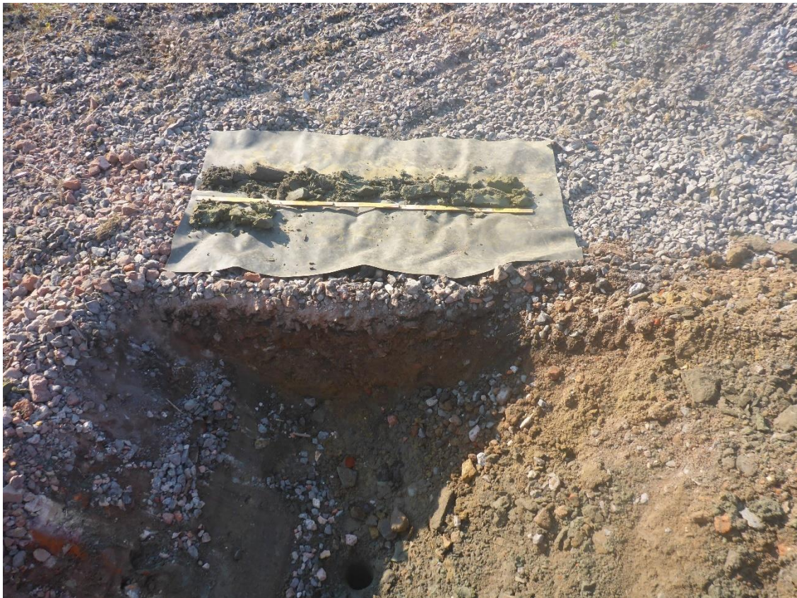
Figuur 2 : voorbeeld van methodiek met machinale verwijdering van de verharding en handmatig verderzetten van de boring.
